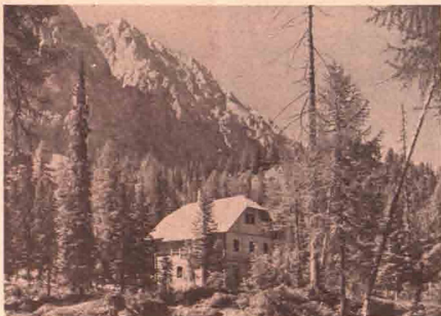
Comptonhütte mit Reiskofel (kurz vor ihrer Fertigstellung)
