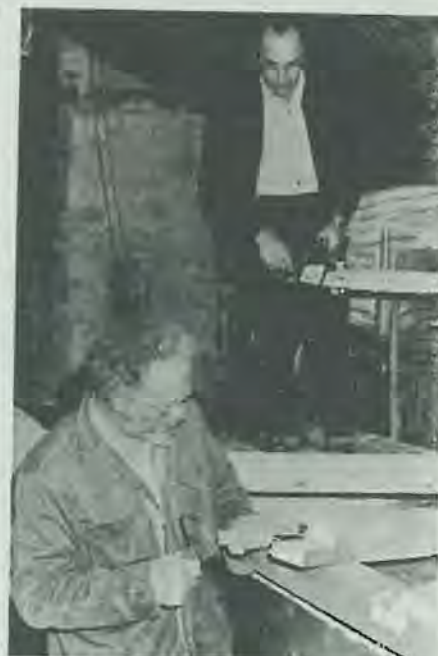
Bau der Balkenlager für die neuen Wassertanks. Klaus Kundt und Gerhard Zahl (stehend) bei der Arbeit am 1. Tag der „Tourenwoche“.
