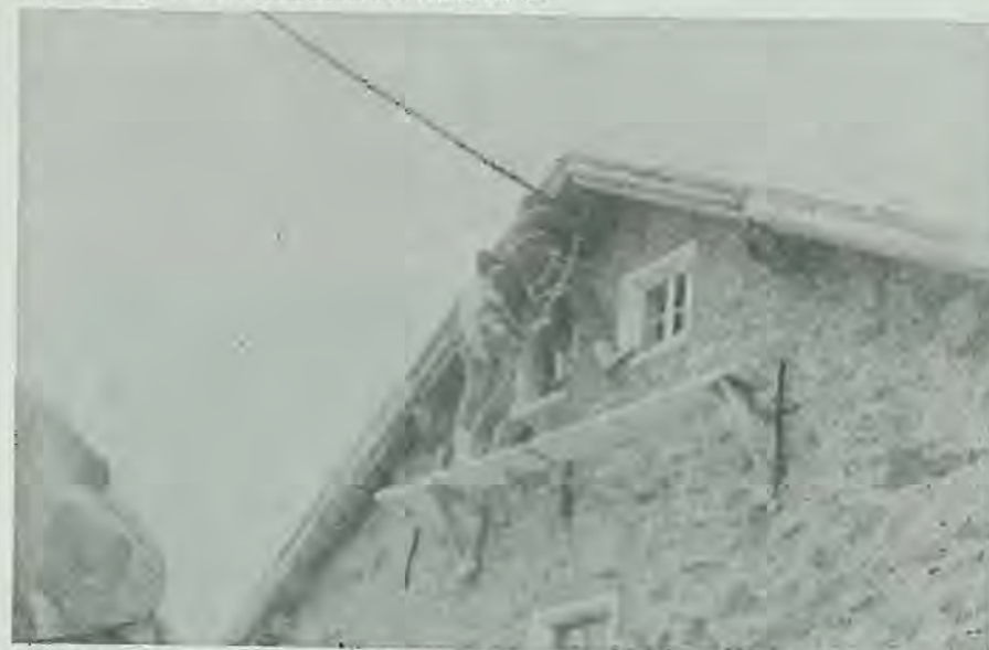
Martin und Fritz vermauern das Loch unter dem Dachfirst, das für die Wasserleitung gestemmt werden mußte.
