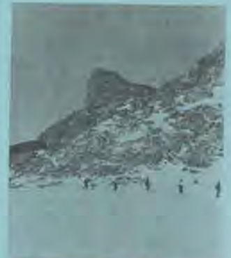
Die Baustelle in den Jahren von 1904 bis 1909, mit Baracke für die Bauarbeiter.
