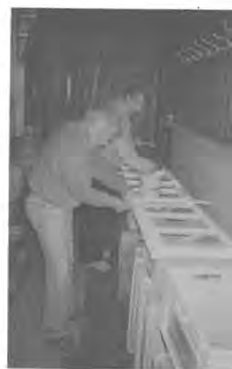
Die vorwiegende Arbeit gehörte der Sanierung der Fenster.
