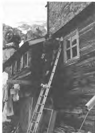
Einbau des neuen Fensters.
