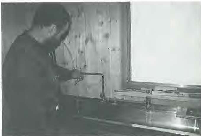
Die neue Verschalung ist fertig, die Wasserhähne funktionieren.
