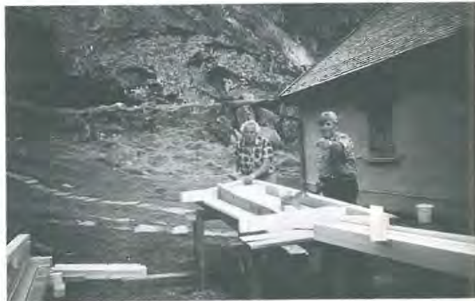
Manfred und Günter erledigten die Zimmererarbeiten
