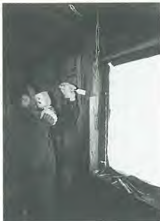
Uwe Pitz beim Herausreißen der alten Verschalung und des Fensters im Waschraum.
