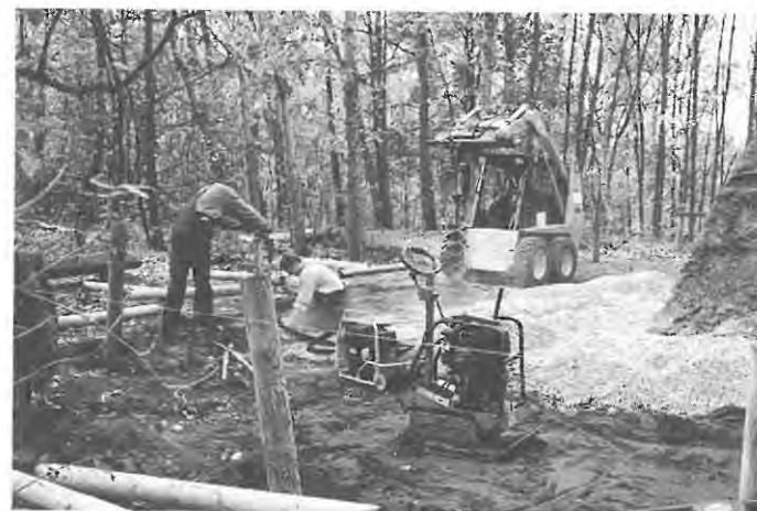
Mit Hilfe von kleinem Großgerät sanierten Rainer Gebel und seine Mannen das Umfeld des Kletterturmes. Foto: Gebel
