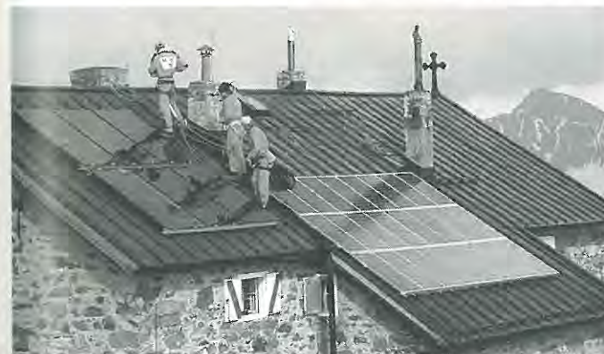
Montage der 24 Quadratmeter Photovoltaikpaneele auf dem Dach für die Elektroversorgung.
