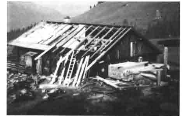
Die abgedeckte Simbacher Hütte.
