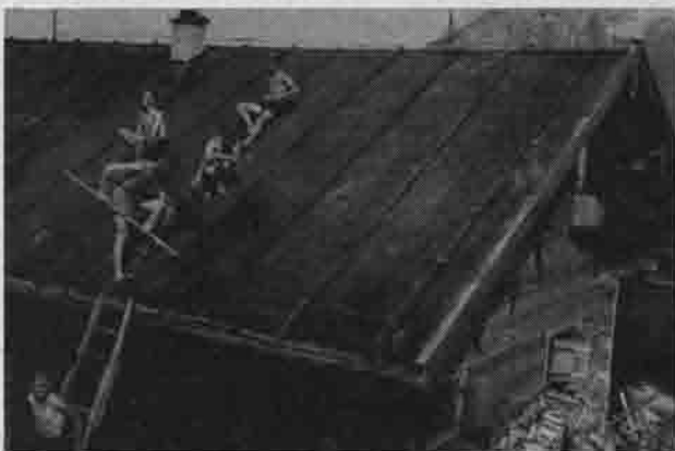
Im Jahre 1937 wurde das Dach geteert.
