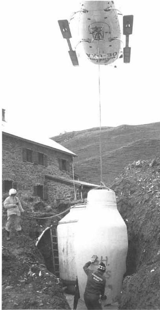
*Die Behälter der Kläranlage werden mit der Hilfe eines Hubschraubers millimetergenau eingesetzt.*
