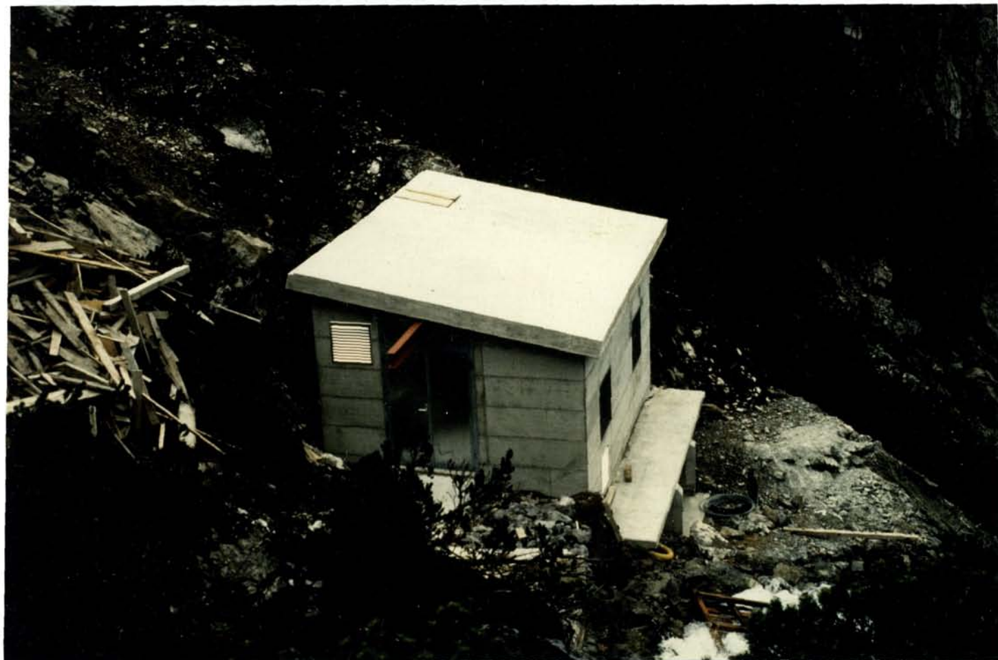
Ende September 1989 steigen die Bauarbeiter der Firma Frick, Reutte, ab. Das Maschinenhaus ist fertiggestellt
