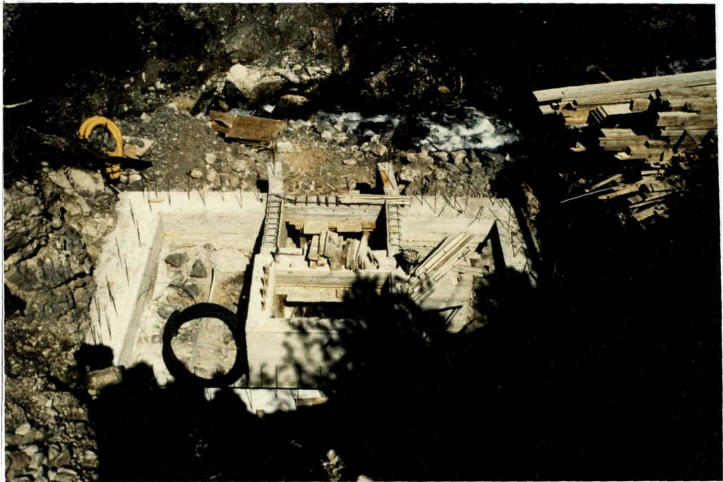
Das scheinbar viel zu große Loch für das Maschinenhaus ist darauf zurückzuführen, daß der Boden immer nachrutschte und keine senkrechte Wand ausgeschachtet werden konnte. Am Boden des Maschinenhauses ist die Ausschachtung also keineswegs zu groß, und beim Setzen des Fundamentes erwies sie sich als gerade richtig.
