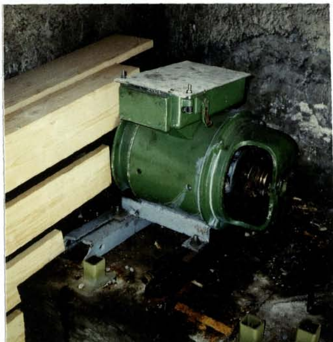
Die Dynamomaschine leistet 25 Ampere bei 220 Volt, rund 5,5 PS bei 1120 U/min
