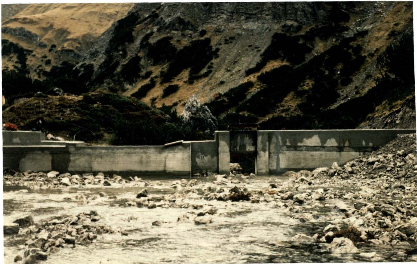
Staumauer und Entsander sind 1987 fertiggestellt
