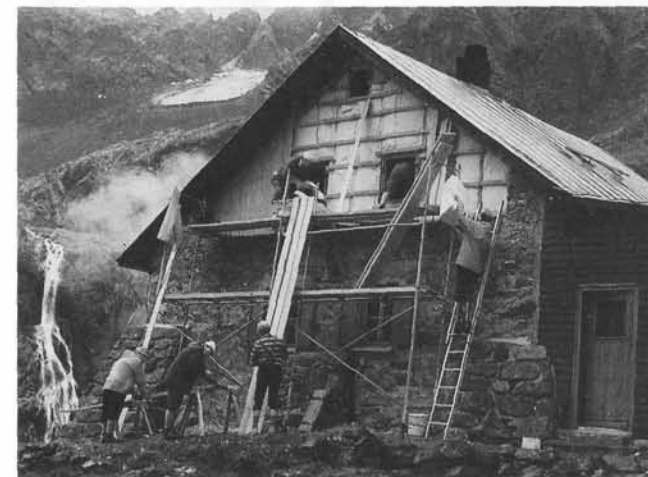
Giebelwandisolierung
