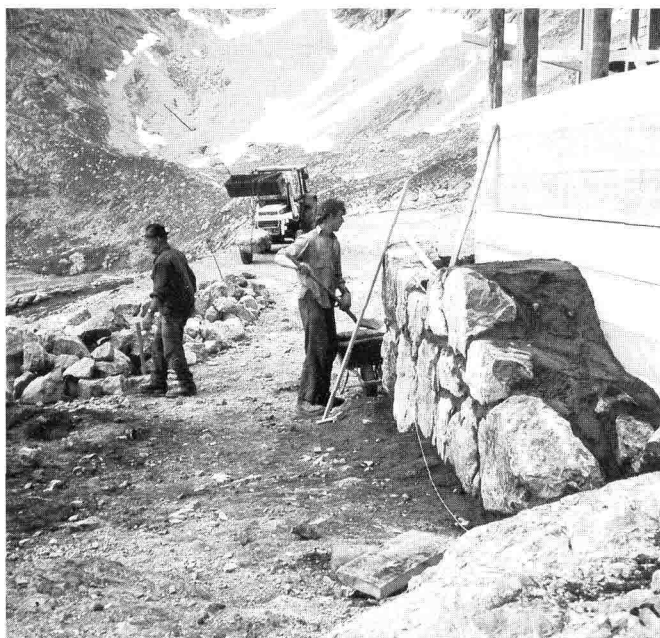
Terrassenbau – Steine mußten aus dem Tal heraufgebracht werden
