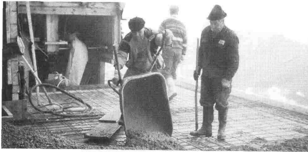
Das Fundament wird betoniert
