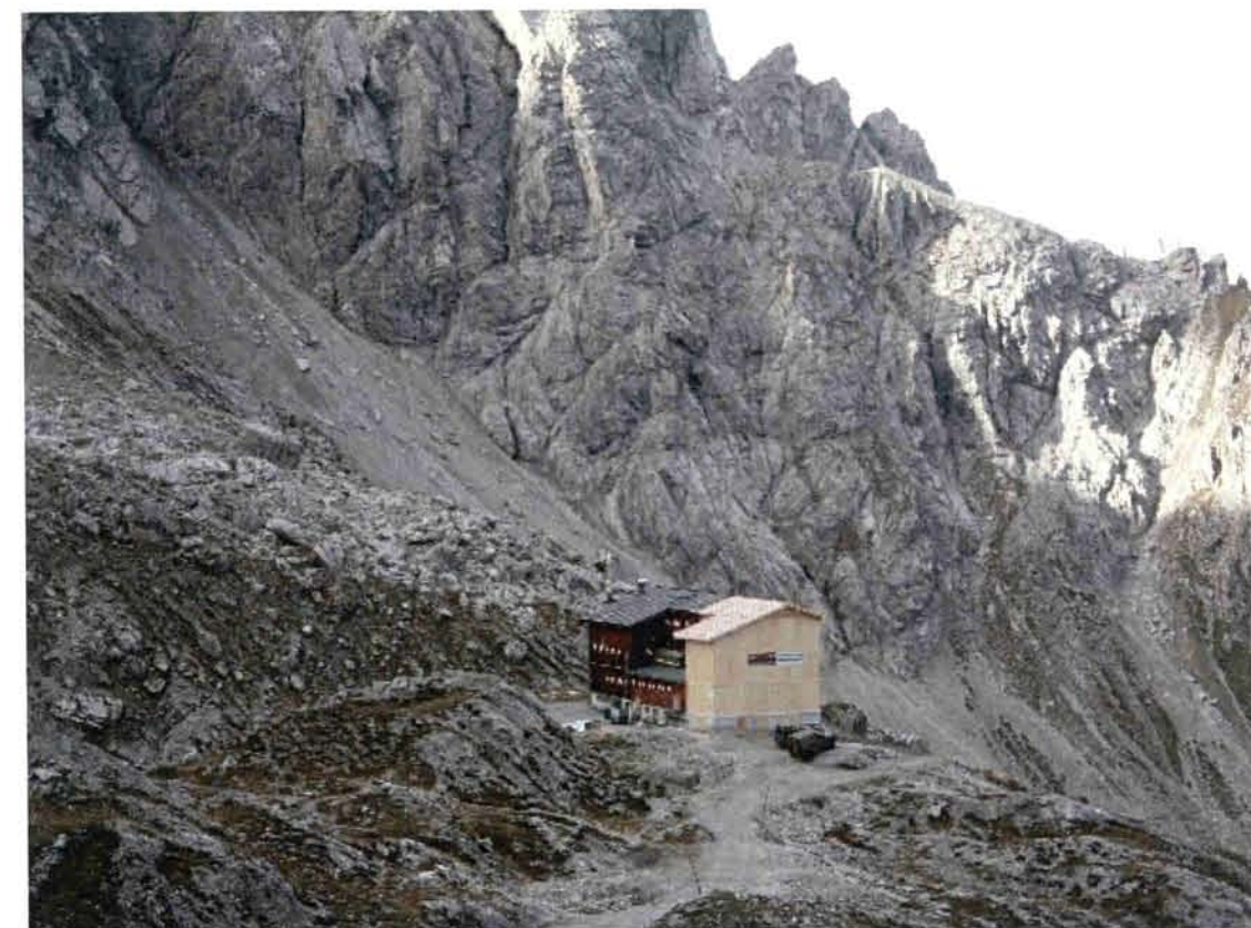
Der Anbau – Nord-Ost-Ansicht
