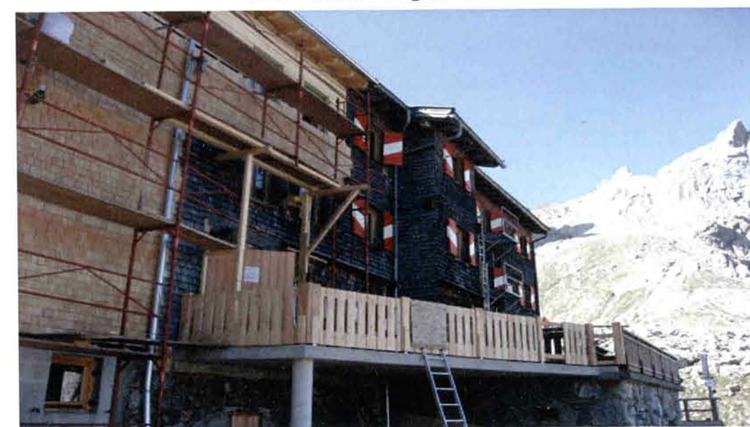
Verschindelungsarbeiten
