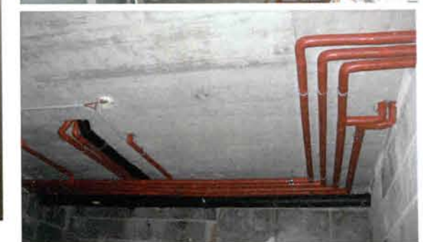
Viele neue Rohre mussten verlegt werden
