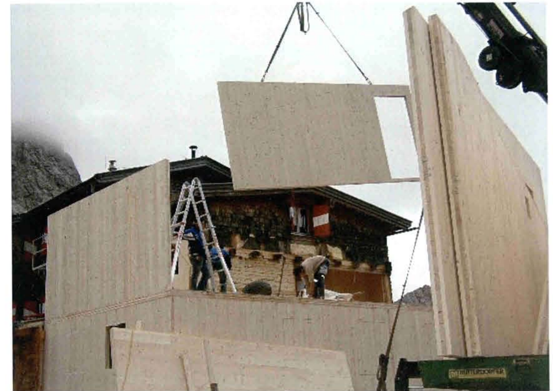
Die vorgefertigten Holzteile werden zusammengesetzt
