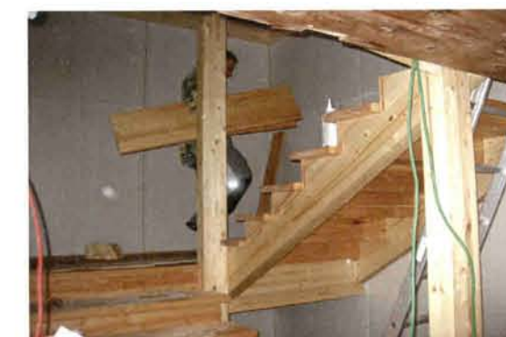
Treppen werden verlegt
