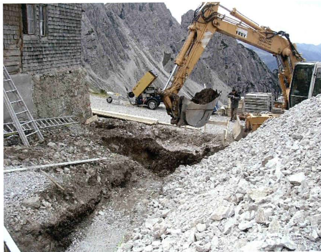
Ausgrabungsarbeiten für die Fundamente
