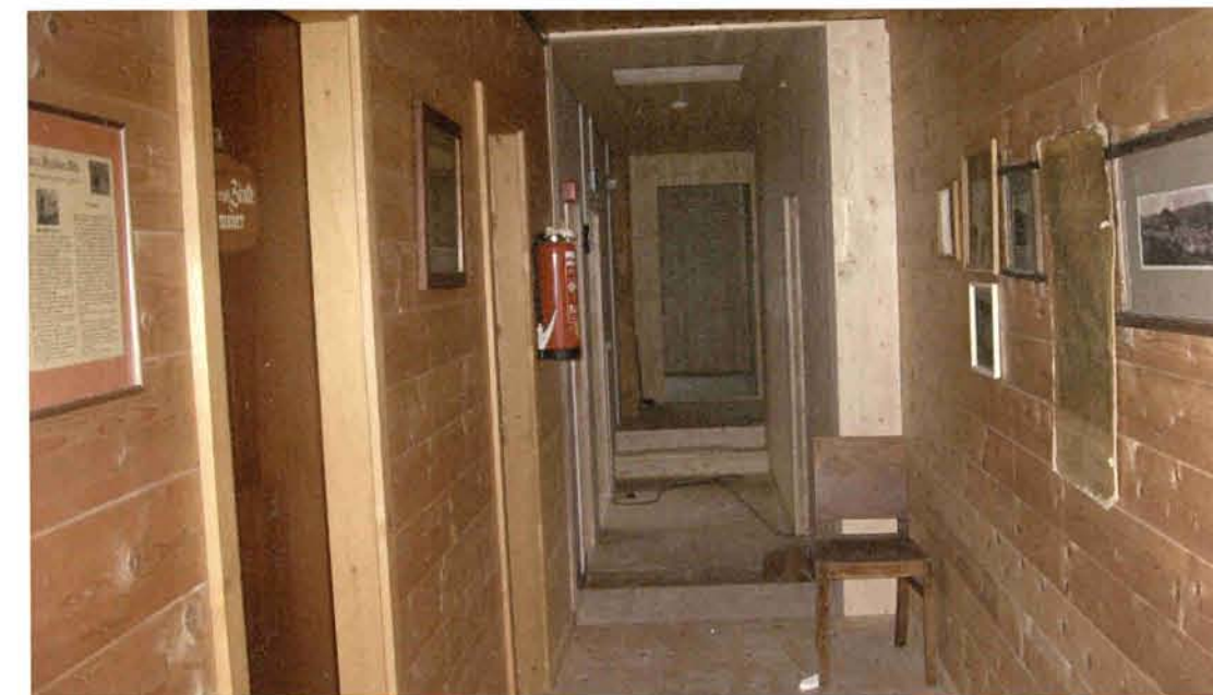
Übergang zwischen Alt- und Neubau
