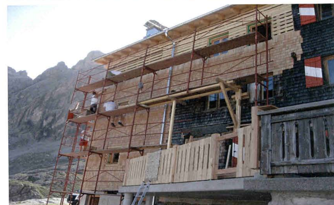
Verschindelungsarbeiten
