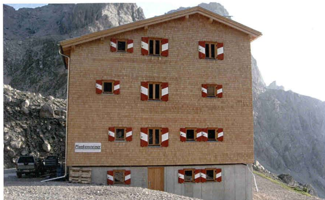
Beim Anbau sind wieder Holzschindeln angebracht worden.
