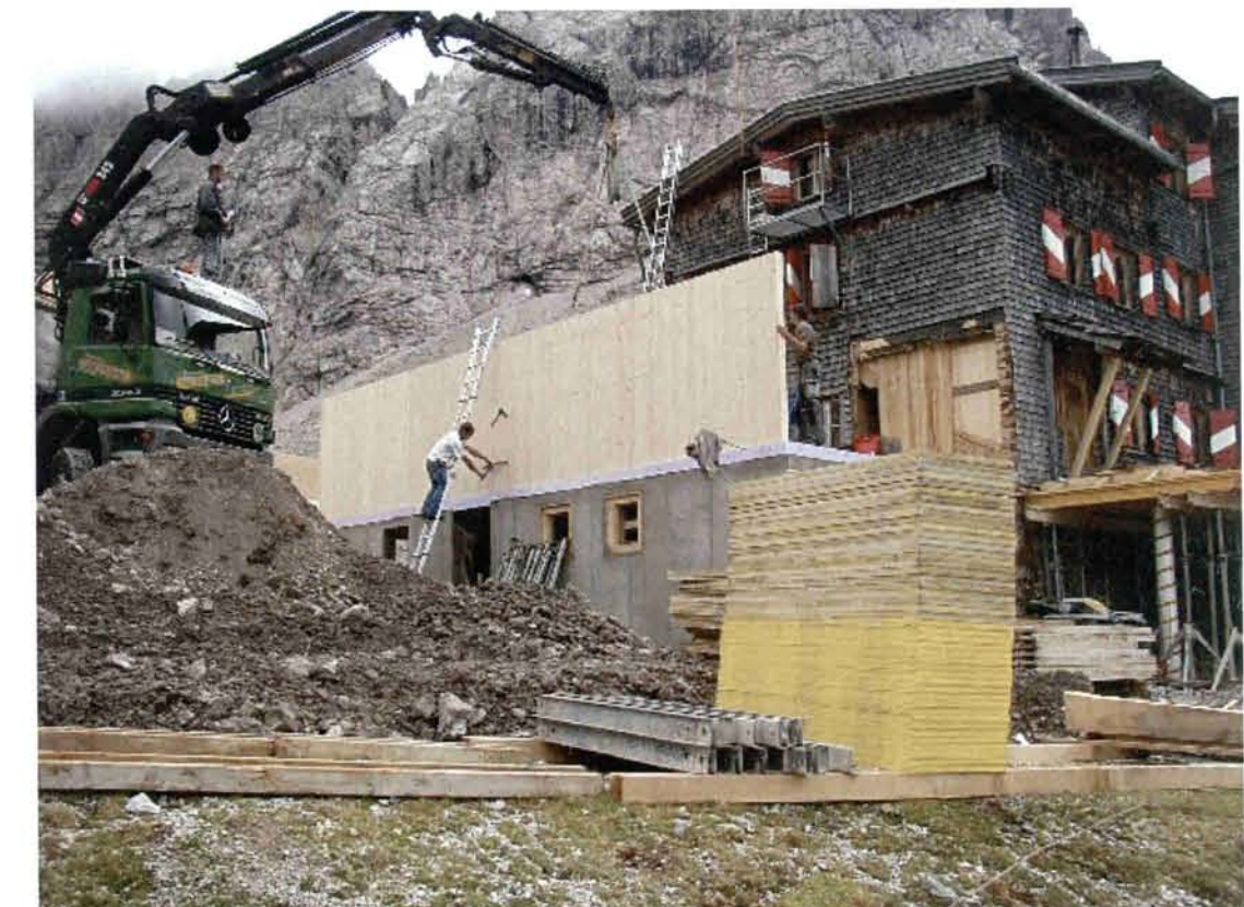
Die ersten Holzwände werden gesetzt
