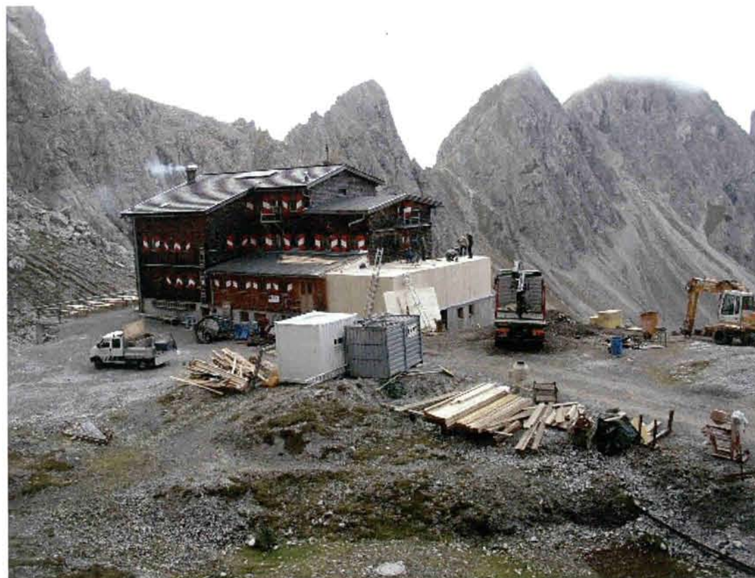
Das Erdgeschoss ist bereits fertig
