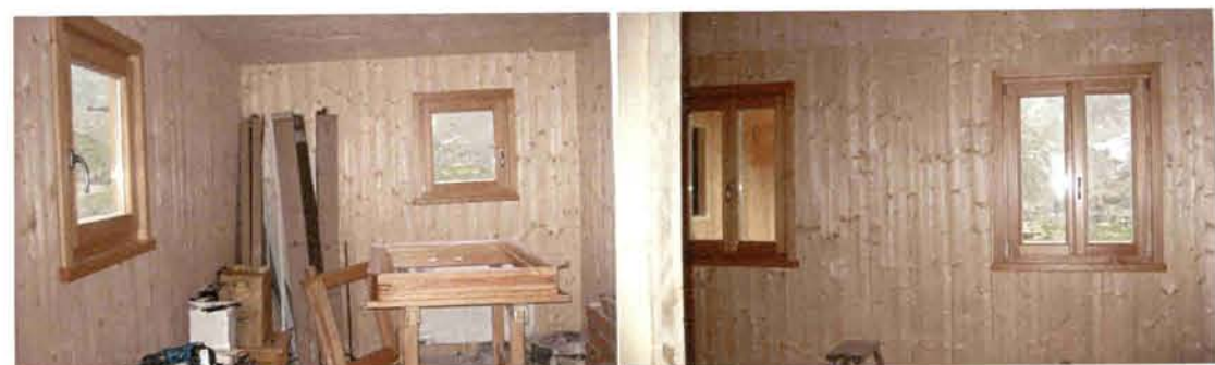
Die ersten Fenster sind gesetzt
