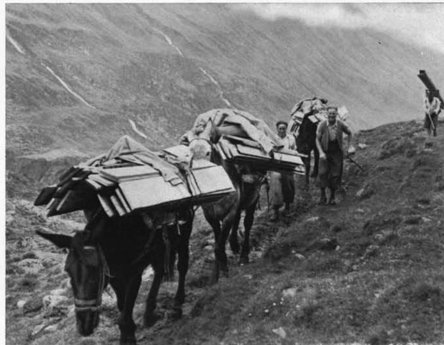
Transport-Schwierigkeiten. Für den Neubau mußten 120000 kg mittels Geländewagen, Muli und Drahtseilbahn auf 2883 m hinaufgeschafft werden. Bild 1: Ein Kasten wird über den Gletscher getragen. — Bild 2: Im Schnee eingebrochener Muli. — Bild 3: Baumaterialienkarawane unterwegs. (Bild 1 und 2 Aufn.: Pohl, Bild 3 Aufn.: Straffer)
