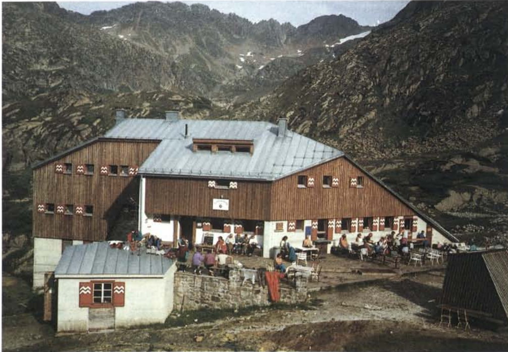
Die neuerstandene Sulzenauhütte (2191 m)
