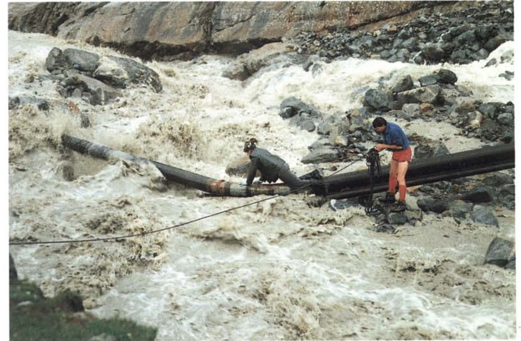
1987 zerstörte ein gewaltiges Hochwasser das Einlaufbauwerk für unser Hüttenkraftwerk. Hier wird der Trinkwasserschlauch wieder am Druckrohr befestigt (zum Beitrag auf S. 57)
