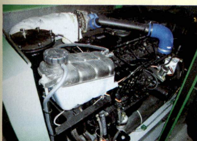
Der Motor des neuen BHKW
