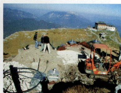
Verfüllung der Wassertanks
