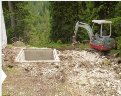
Da die Klärgrube zu klein und undicht war, wurde ein neuer Sammelbehälter betoniert.
