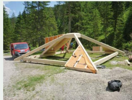
Die für die Dachsanierung benötigten Elemente wurden im Tal vorgefertigt und mittels Hubschrauber zur Baustelle transportiert.
