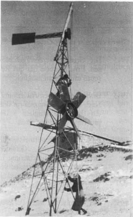
Schon 1935 nutzte Hans Frey die Windenergie zur Stromerzeugung
