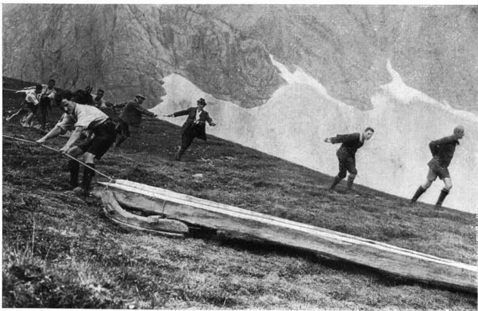
Arbeitsdienst beim Bau der Falkenhütte (Balken-Sprengen)
