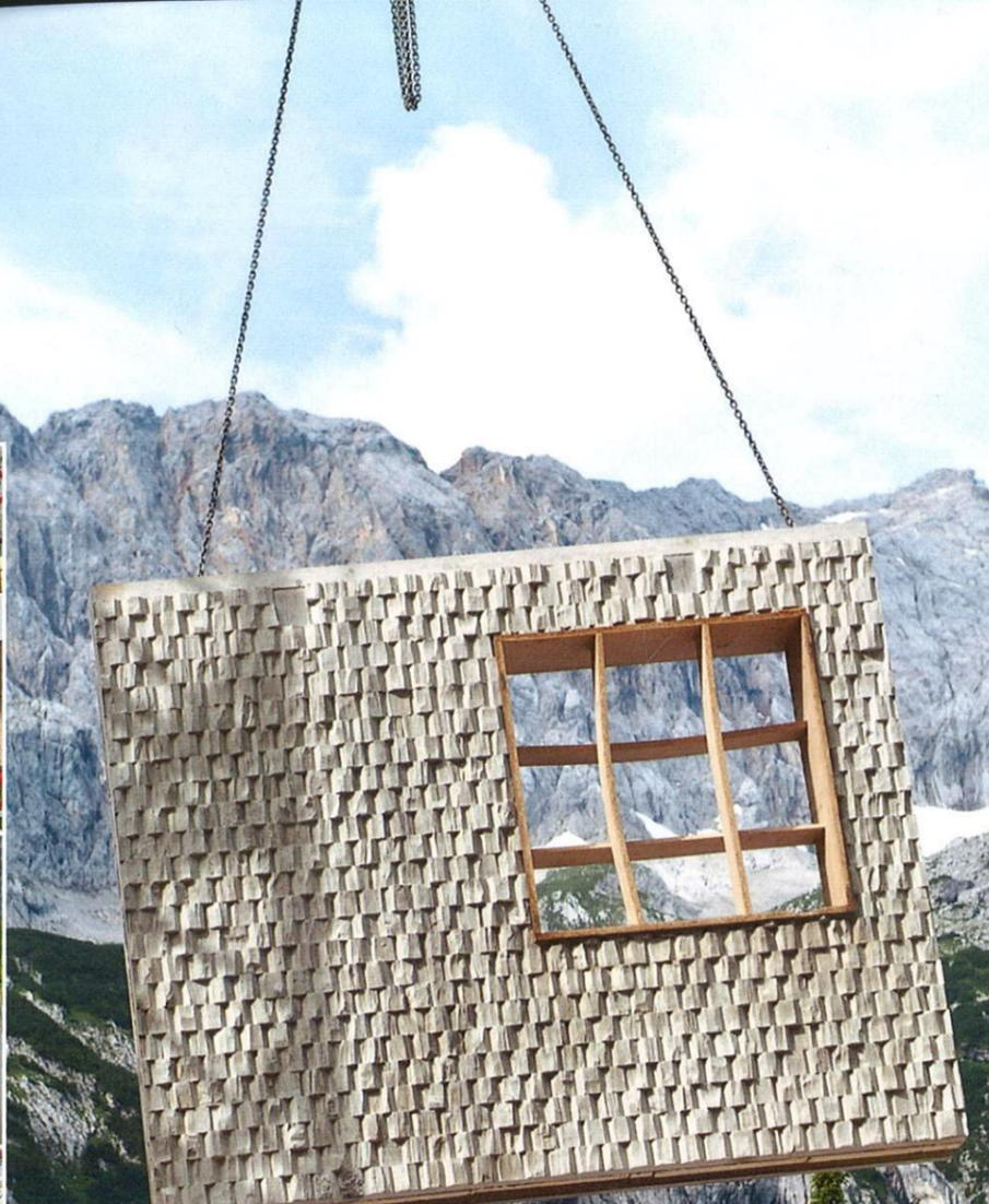
Die Wandelemente für die Außenwand im Untergeschoss werden eingeflogen und mit dem Kran an Ort und Stelle gesetzt. Außen mit einer gefälligen Struktur versehen, innen bereits mit eingebauter Dämmung versehen. Aufstellen, ausrichten, ausgießen fertig...
