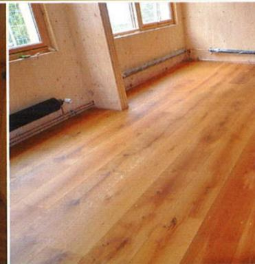
In handwerklicher Perfektion und mit ganz viel Liebe zum Detail wurde der Holzboden im Gastraum eingebaut. Stabile Eichenläden wurden dazu in fallenden Längen sorgfältigst mit der Unterkonstruktion verschraubt und der Boden zum Schluss geölt. Fast möchte man ein Schild "Schuhe ausziehen" aufhängen. Aber bei der Dicke der Eichenbretter werden wohl wieder 100 Jahre vergehen bis man hier über einen Austausch nachdenkt...
