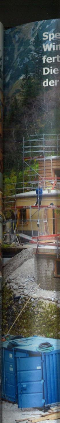
Spengler und Zimmerer arbeiten jetzt Hand in Hand, um das Dach und die Fassade vor dem Winter noch dicht zu bekommen. Im Obergeschoss ist der Unterbau für die Verschindelung schon fertig, im Erdgeschoss muss noch die Dämmung eingebaut werden. Die bergseitige Hinterfüllung der Hütte ist schon fast fertig und die seitliche Stützwände hinter der Hütte geben der Hinterfüllung ausreichend Halt.
