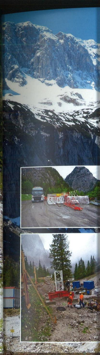
Bis der Baukran gestellt werden konnte, musste nach dem Winter erst einmal der Grundbau nachgearbeitet und die Kranfundamente gegossen werden.
