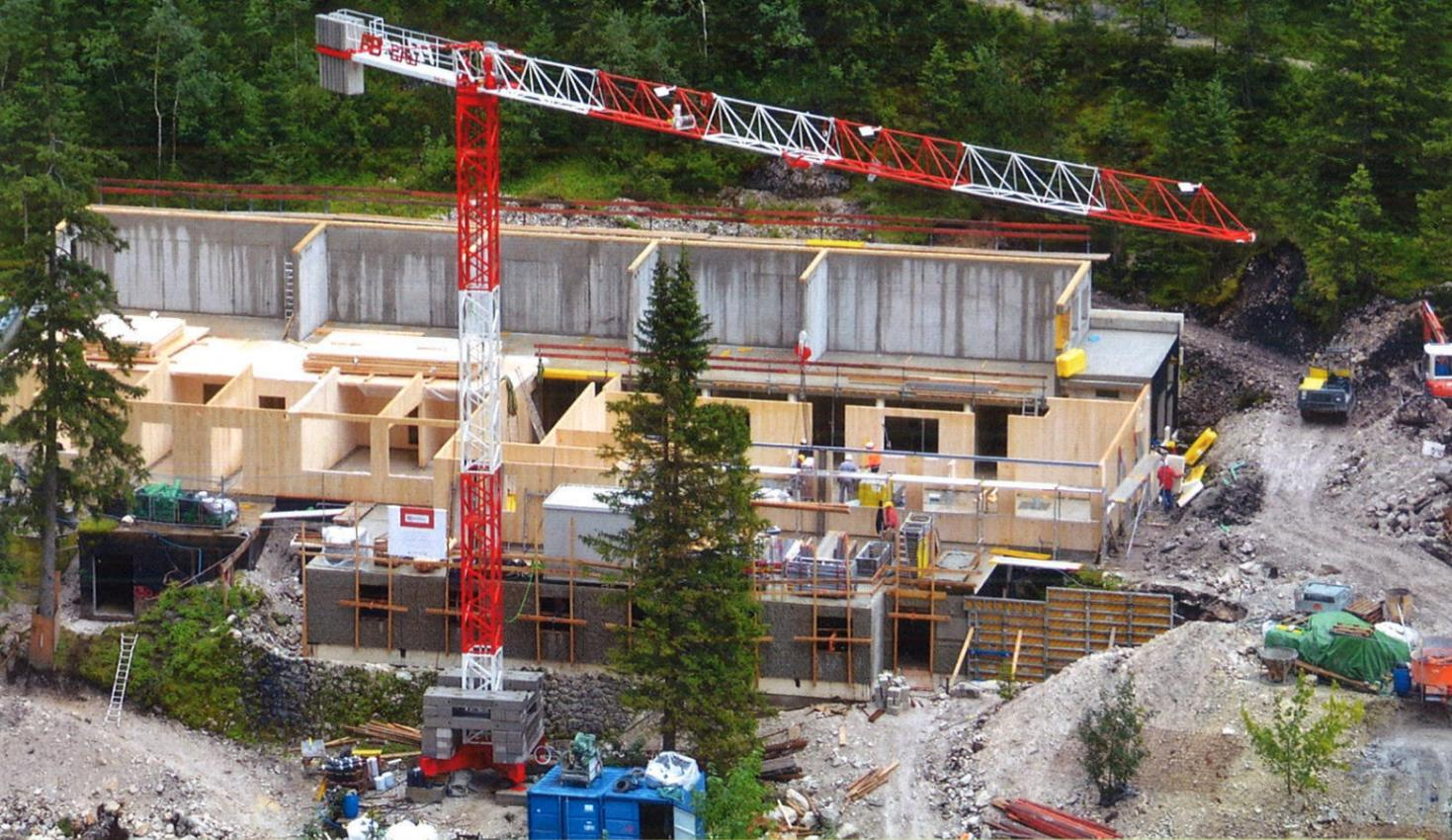
Aberwitzig schnell entstand auf der Baustelle aus den sorgfältig vorbereiteten Holzelementen binnen weniger Stunden bereits ein erstes Raumgefühl. Dort, wo vor wenigen Stunden noch tristes Betongrau stand, ragten jetzt Hüttenwände in den Himmel.
