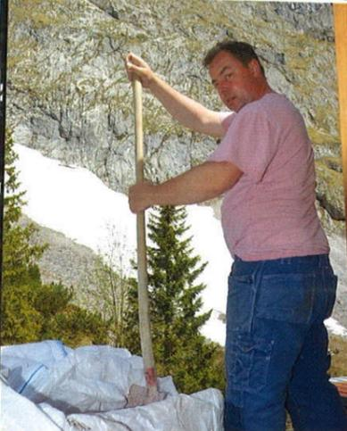
**An allen Ecken wird geschraubt, gebogen, gespaxt, gebohrt, gehobelt: Und binnen kurzer Zeit sind konkrete Ergebnisse sichtbar wie z.B. die fertig montierte Verbundanlage für die Kühlung aller Kühlzellen. Oder aber die Fußböden im Ober-Geschoss: Kaum sind 15 Tonnen Kies von Hand eingeschaufelt und sorgfältig verteilt, schon werden die Bodenbretter verschraubt - und fertig ist der Fußboden.**
