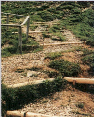
Ca. 60 Festmeter Holz wurden zu neuen Stufen verbaut, um weiteres Eingraben des Weges zu verhindern. Foto: Sabine Bernatz
