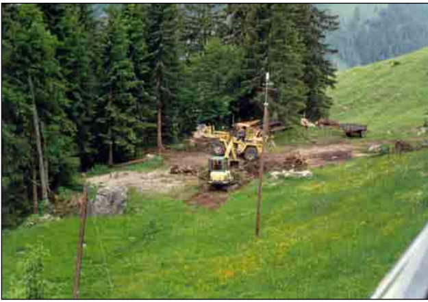
Der Bauplatz wird vorbereitet
