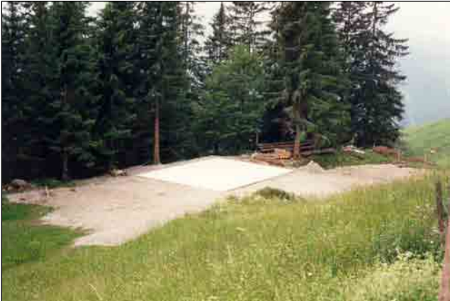
Das Fundament fest gemauert in der Erde
