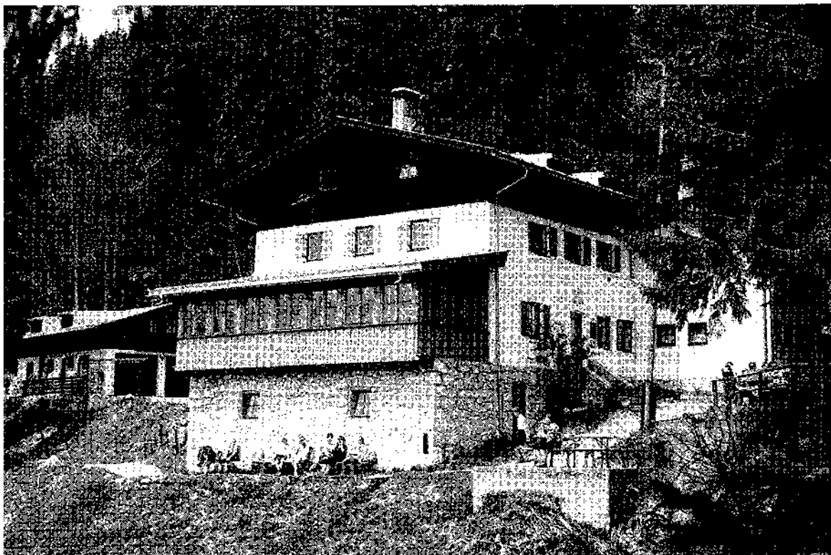
Das „neue“ Brünsteinhaus nach Abschluß der Modernisierungsarbeiten (Aufnahme 1982)
