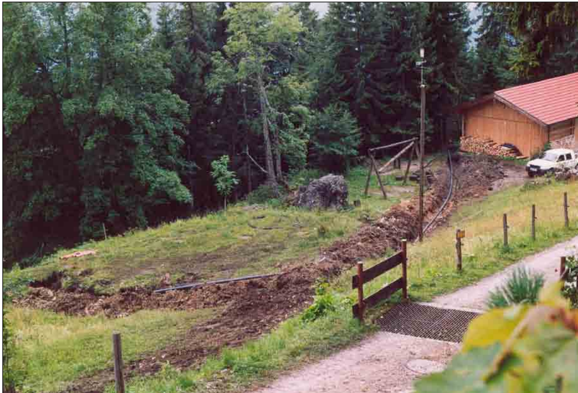
Graben sauber geschlossen. Abflussrohr der Kläranlage.
