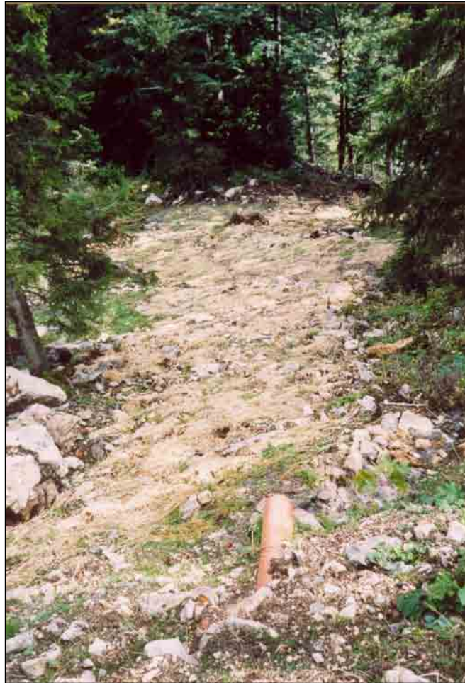
Graben sauber geschlossen. Abflussrohr der Kläranlage.
