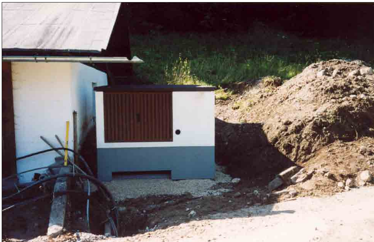
Die neue 20 kV-Kabelstation Rechenau. Eigentum der Gemeinde Kiefersfelden. Anschlussstelle des DAV-Kabels zum Brunnsteinhaus.
