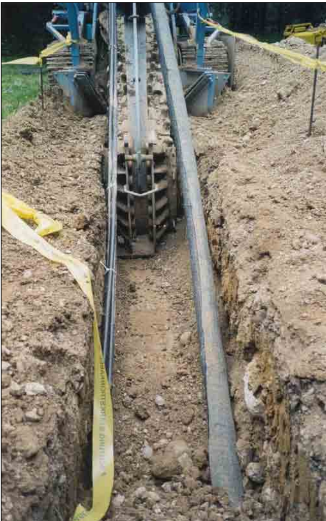
Alles fertig zum Zufüllen
