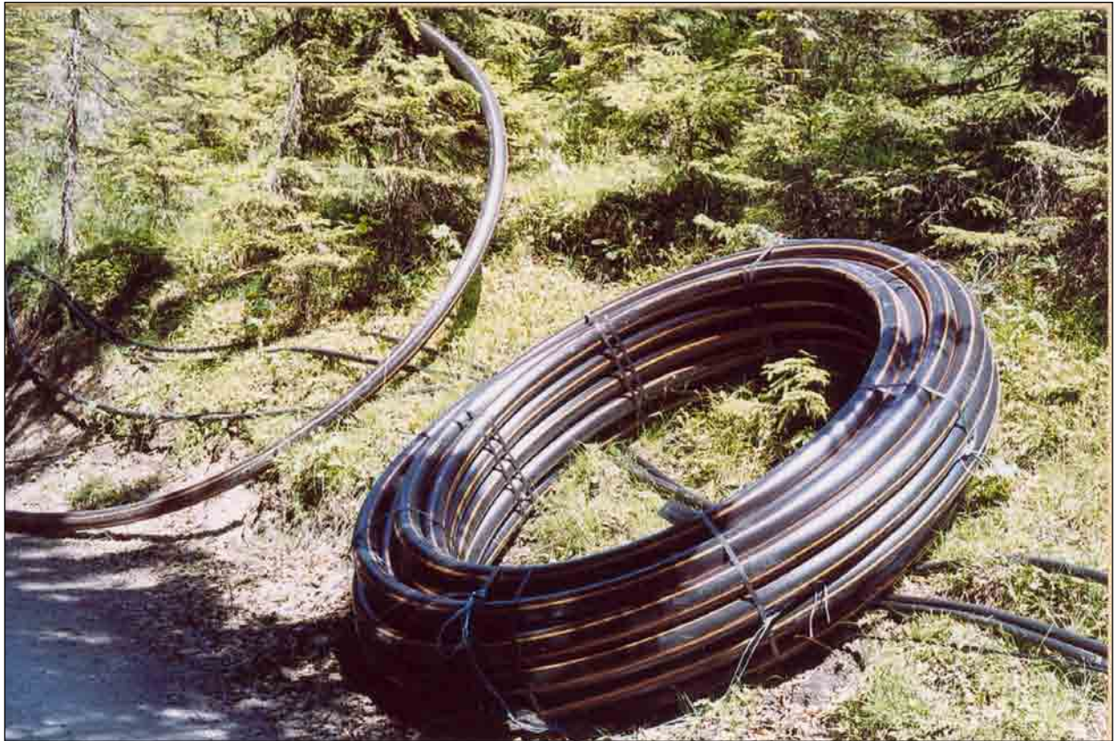
Das Abwasserrohr PE 100 90 x 8,2 mm
