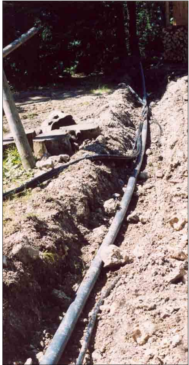
Anschlüsse für Station, Haus und späterer Abwasserpumpstation.
