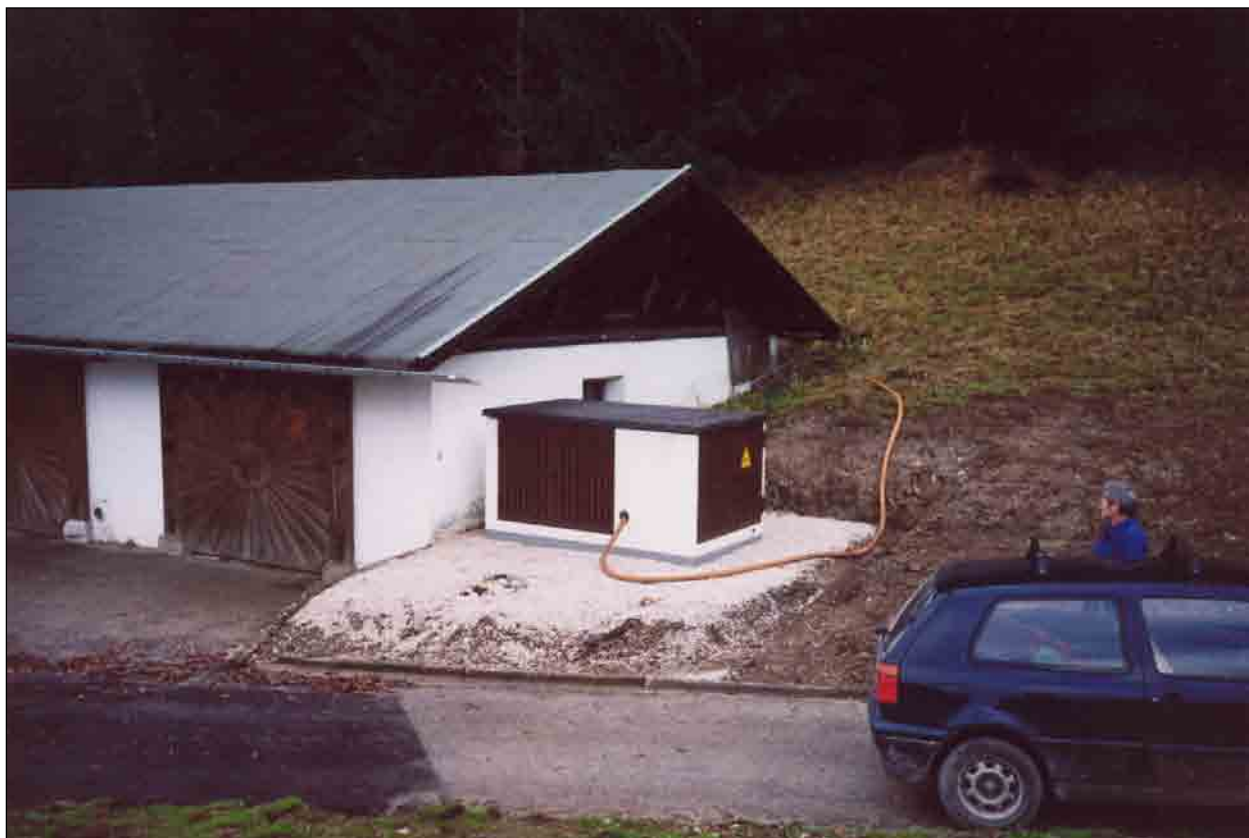
Die neue 20 kV-Kabelstation Rechenau. Eigentum der Gemeinde Kiefersfelden. Anschlussstelle des DAV-Kabels zum Brunnsteinhaus.
