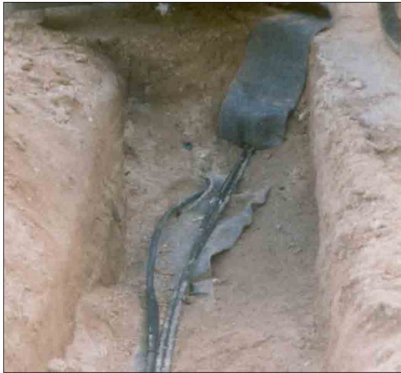
Die 1. 20 kV-Muffe von oben
