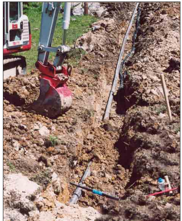
Die Wasserleitung mußte Vorübergehend durchschnitten werden.
