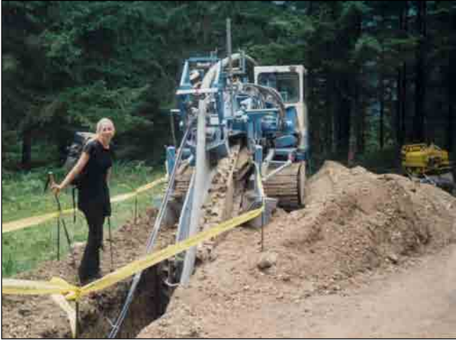
Direkt hinter der Fräse stellte der kleine Bagger die Straße wieder her
