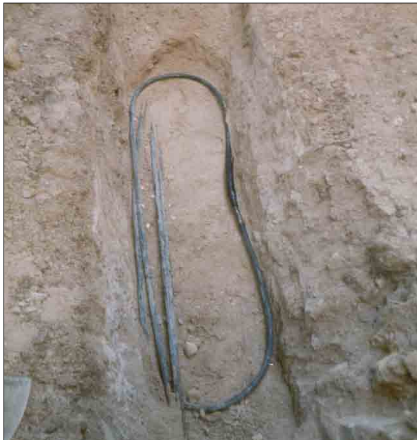
Die 2. 20 kV-Muffe von oben
