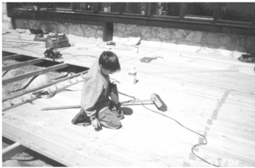
Der Bau der Terrasse nimmt Gestalt an
