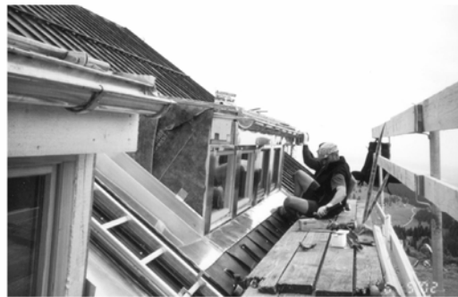
Arbeiten am Dach
