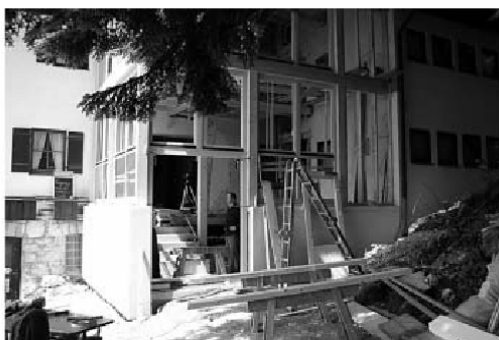
Die Fensterelemente sind gesetzt
