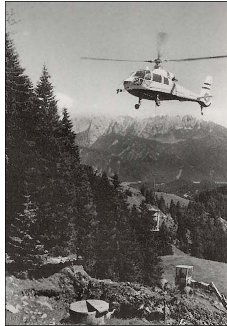
Hubschrauber bei der Erweiterung der Wasserversorgung 1985
