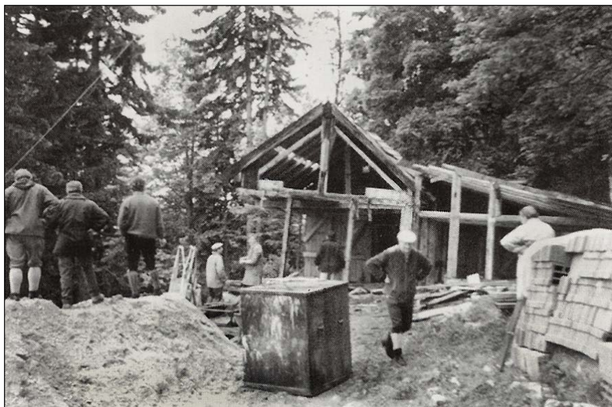
Abbruch des Pferdestalles
