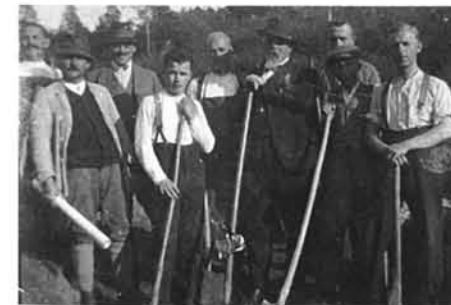
Bau der Edelweißhütte auf dem Mahlberg 1925
