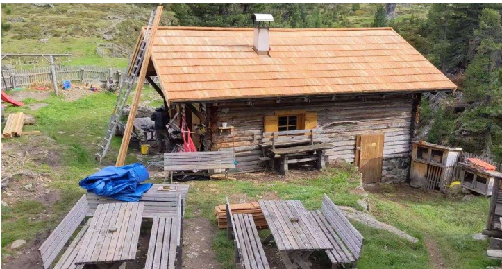
Winterraum mit neuem Dach
