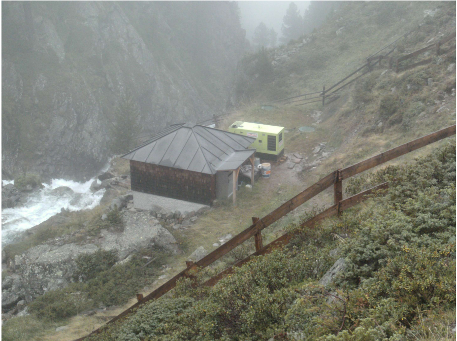
Turbinenhaus (nach Unwetter 2019)
