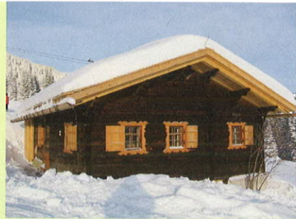
Das Maisäbhäuschen ist eines der wenigen originalen Objekte dieser Art in Vorarlberg. Die Behörden wollten es unter Denkmalschutz stellen, waren aber mit einer Umbaulösung einverstanden. So wurde es zu einer Ferienwohnung mit 5 Übernachtungsmöglichkeiten unter Wahrung der historischen Bausubstanz umgebaut.
