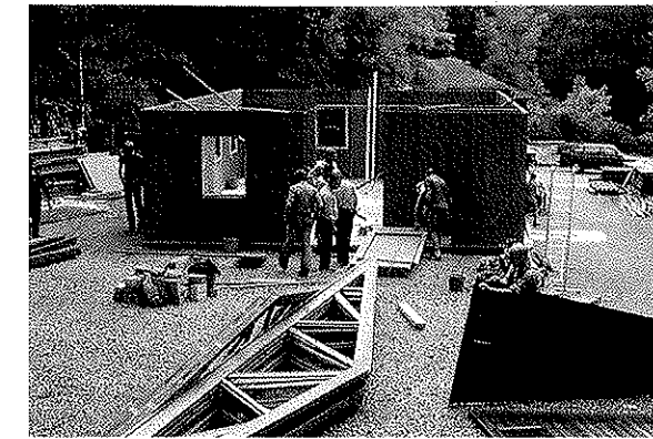
Aufbau der Hütte
