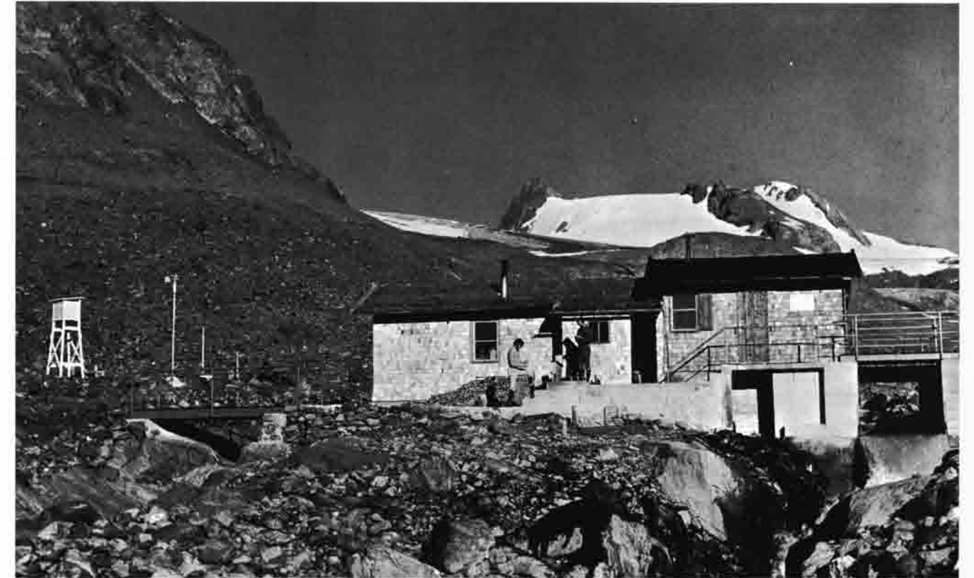
Abb. 10: Ansicht der Pegelstation Vernagtbach nach deren Erweiterung im Sommer 1975. Rechts im Bild ist die Meßrinne mit Überfall erkennbar, die Pegelschreiber befinden sich in der Stationshütte unmittelbar neben der Rinne, der Anbau dient dem Aufenthalt des Personals. Aufnahme O. Reinwarth, 3. Oktober 1975.
