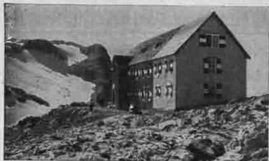
Straßburger Hütte des D. u. Oe. A. V., 2700 m. — Die Außen- und Zwischenwände des 1930 ausgeführten Anbaues wurden in Heraklith erstellt, außerdem wurde das Dachgeschoß mit Heraklith ausgebaut
