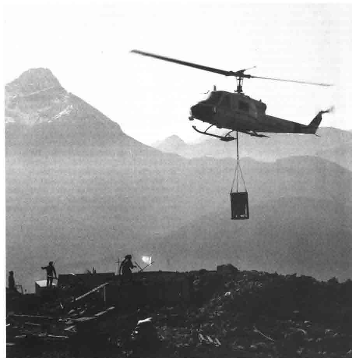
Bau des Wasserspeichers - der Fertigbeton kommt mit dem Hubschrauber.
