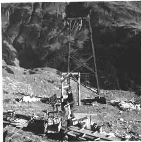
Bau der Materialseilbahn 1968.
