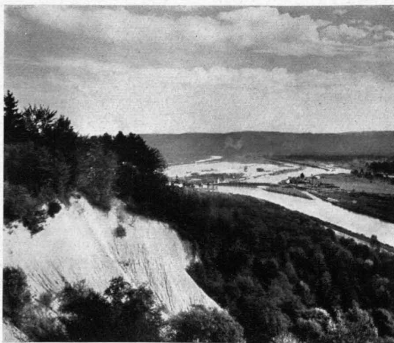
Abb. 14. Blick von Icking gegen Norden. Die nunmehr vereinten Wasser der Isar und Loisach werden in einem Kanal (Bildmitte rechts) dem Kraftwerk Mühlthal zugeführt. Links vorne tonig durchsetzter Moränenschutt (Würmeiszeit) und auf grundwasserfeuchten Hängen dichte Weidenbestände
