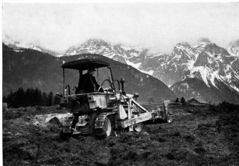
Die Planierraupen bei der Arbeit östlich der Hochstraße (Aufn.: 7.5.1958)
