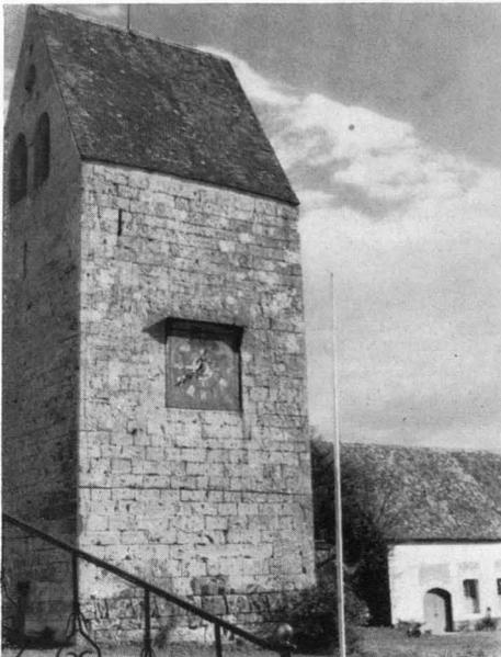
Abb. 4 Der Glocken- und Wehrturm des alten Klosters Wessobrunn führt in das 13. Jahrhundert zurück. „Der graue Herzog“ — wie man ihn nennt — ist aus mächtigen Kalktuffquadern erbaut
