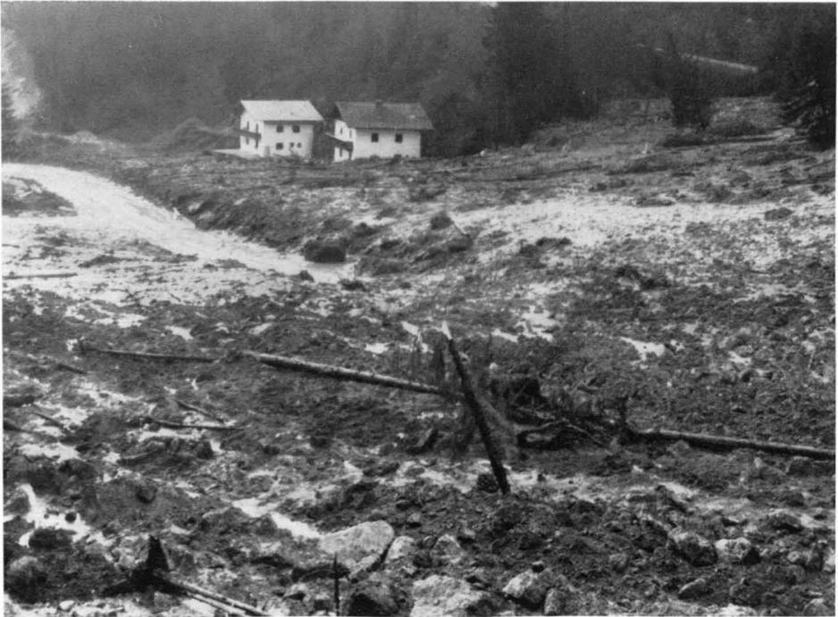
*Abb. 6 Mehrmals wurde versucht, die Bundesstraße 174 freizulegen. Ständig nachfließendes Murenmaterial machte alle Anstrengungen zunichte. — Im Winter erst konnte auf und über die Mure eine Fahrbahn gelegt werden*
