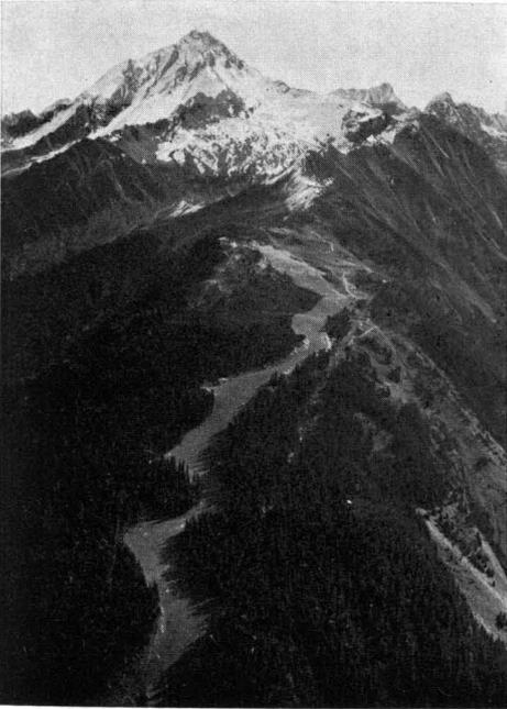
Abb. 9 Gut in die Landschaft eingefügte Skipiste; zur Verhinderung des konzentrierten Wasserabflusses immer wieder seitlich versetzt. Trotz Felsabtrag im oberen Drittel bis 8 m entstanden keine Schäden am Bestand. Gut gepflegte Begrünung. Im oberen Teil durch Rinderweide genutzt.
