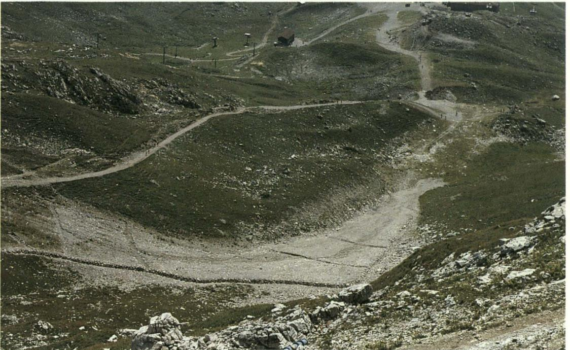
Foto 4: Das Bild zeigt eine großflächige Planierung mit Drainagegräben als Beispiel für Flächenveränderungen im Rahmen des Skipistenbaus (Skigebiet OA17 Nebelhorn). Foto: Dietmann
