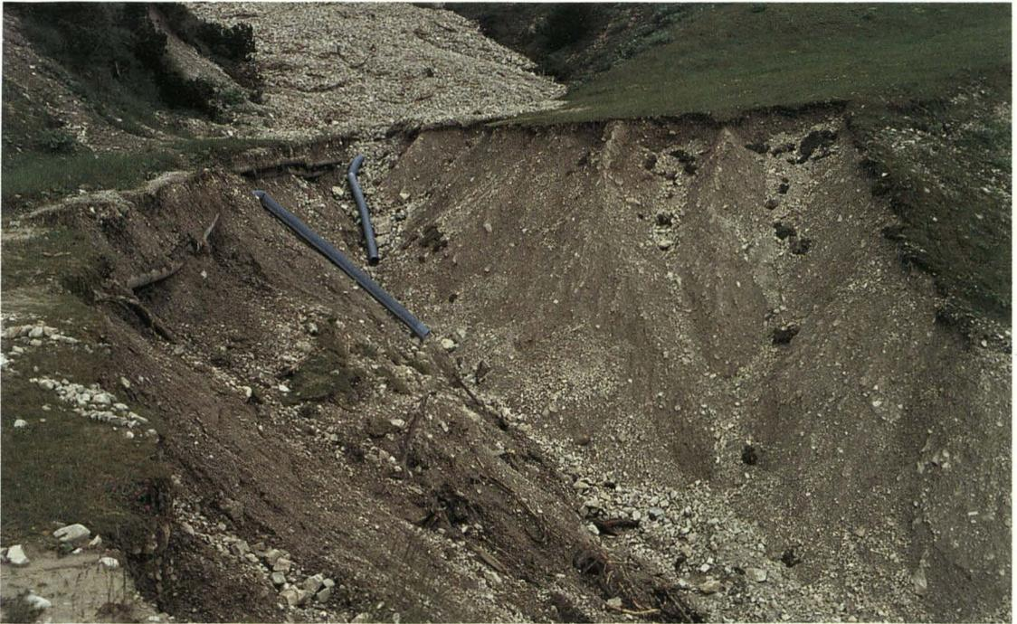
Foto 12: Geländeänderungen im Rahmen des Skipistenbaus bieten oft Ansatzpunkte für erhebliche Erosionsschäden. Das Bild zeigt eine durch einen Starkregen abgeschwemmte Aufschüttung einer Skipiste (Skigebiet OA18 Oberjoch).
