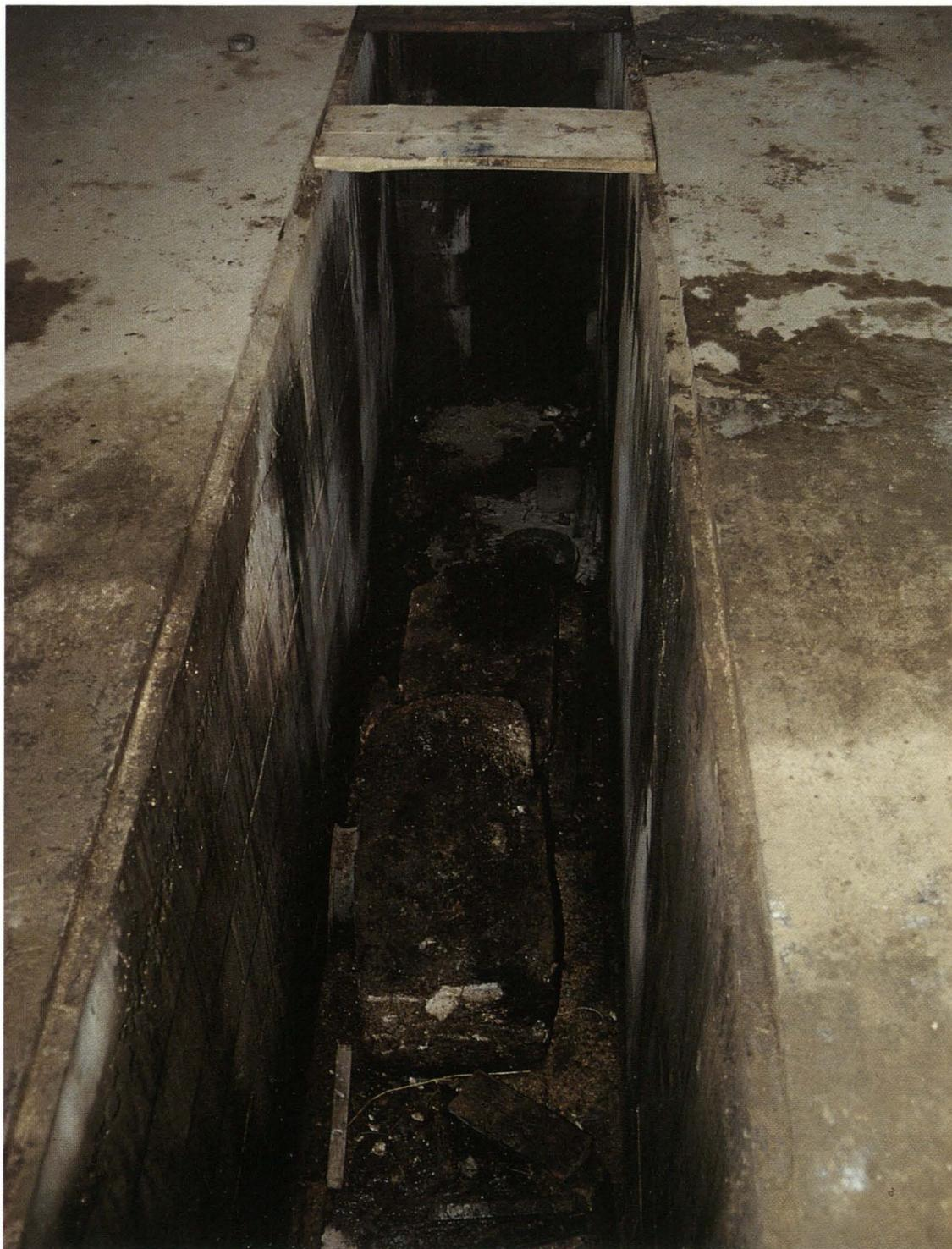
Foto 20: Im Tiefgeschoß der Talstation von Lift II befinden sich Montagegruben zur Wartung der Pistenraupen. Hier wurde eine Bodenverunreinigung durch Mineralöl festgestellt
