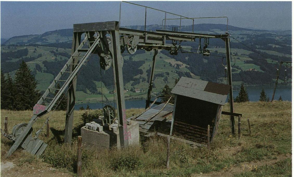
Foto 4: Die Bergstation von Lift I mit liegend gelagerter Umlenkscheibe, Spannwagen, Spannungswicht und Kontrollkabine an der Ausstiegsstelle.
