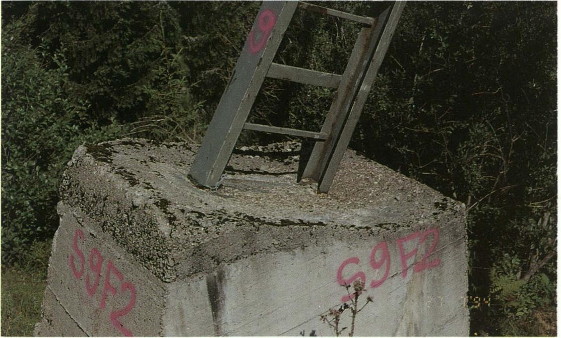
Foto 3: Liftstütze mit Fundament aus Stahlbeton.
