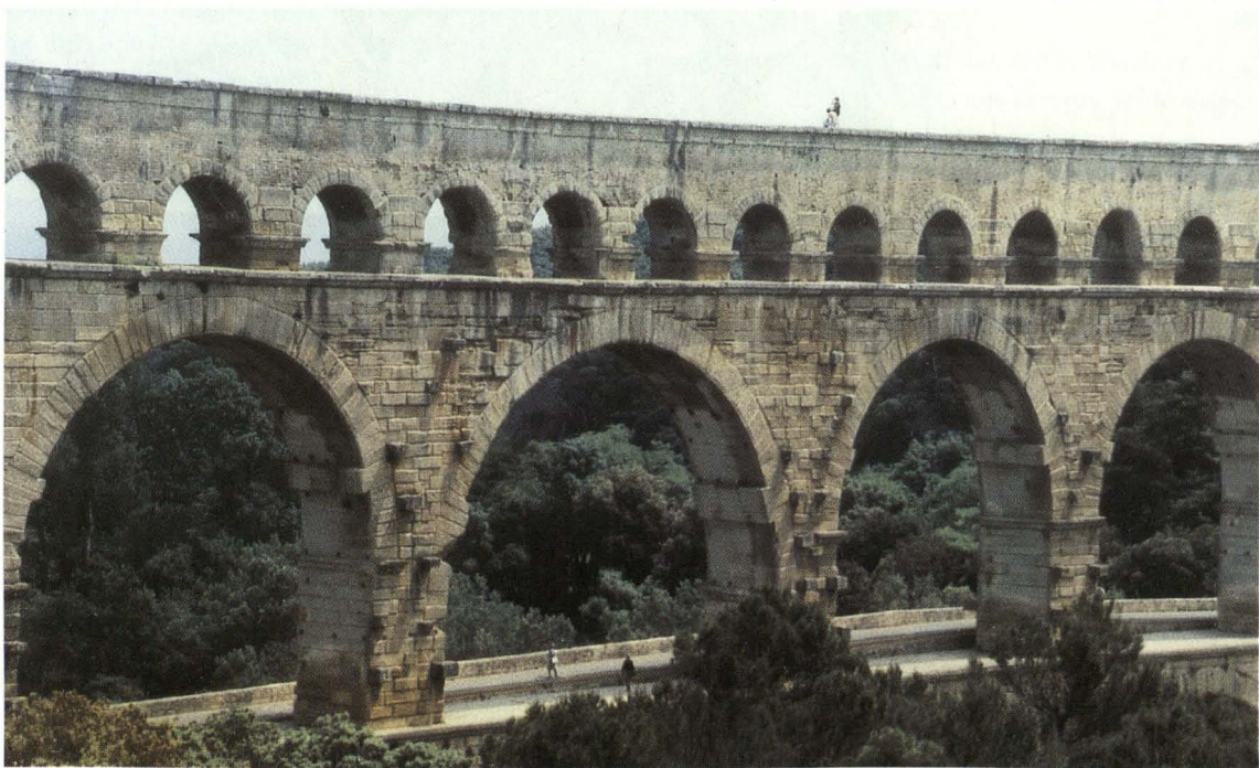
Abb. 5: Auf dem Scheitel des römischen Aquäduktes „Pont du Gard“ verlief die Wasserleitung, die Trinkwasser von Quellen bei Uzès nach Nîmes leitete.
