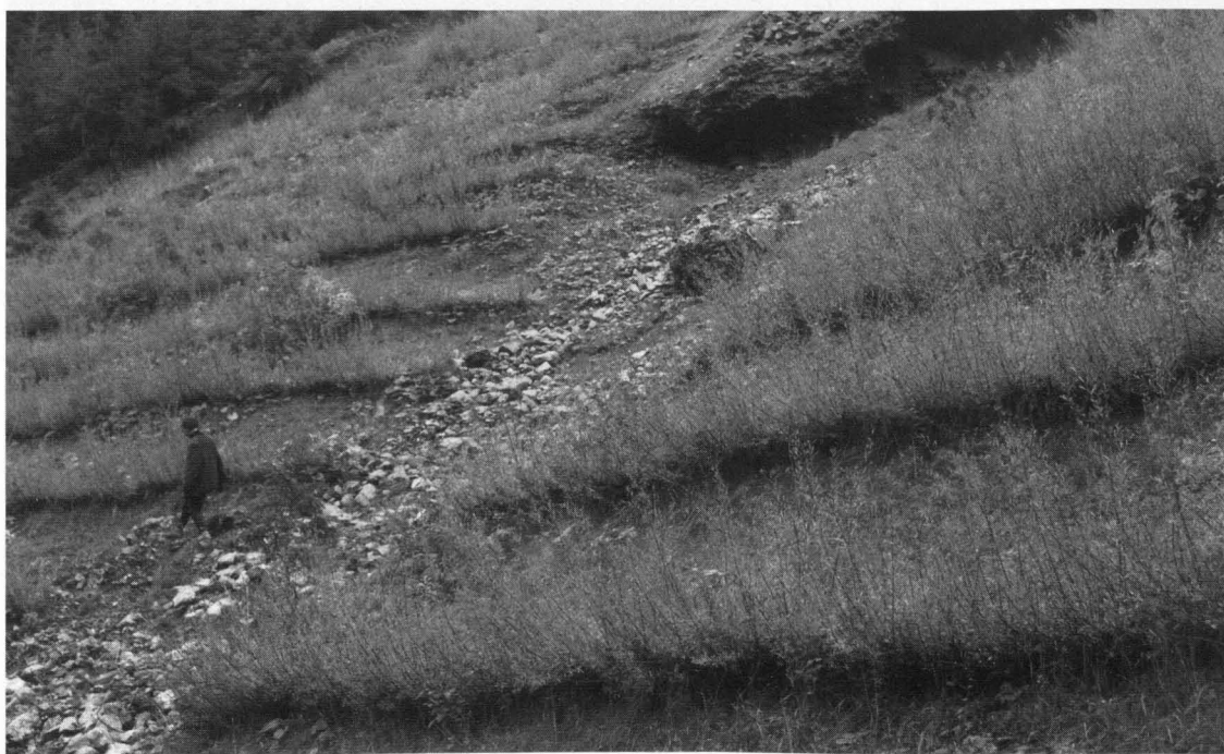
Abb. 5: Ingenieurbiologische Sanierung eines Rutschhangs durch Gehölzpflanzung in Kombination mit technischer Verbauung. Langfristiges Ziel ist eine stabile Wiederbestockung der Fläche
