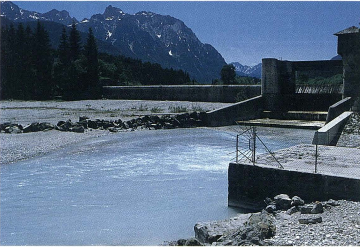
Abb. 3.9: Am Krüner Wehr wird die Isar in den Walchensee zur Gewinnung elektrischer Energie abgeleitet. Das ankommende Geschiebe wird zum Teil bei Hochwasser in das ursprüngliche Isarbett gespült.
