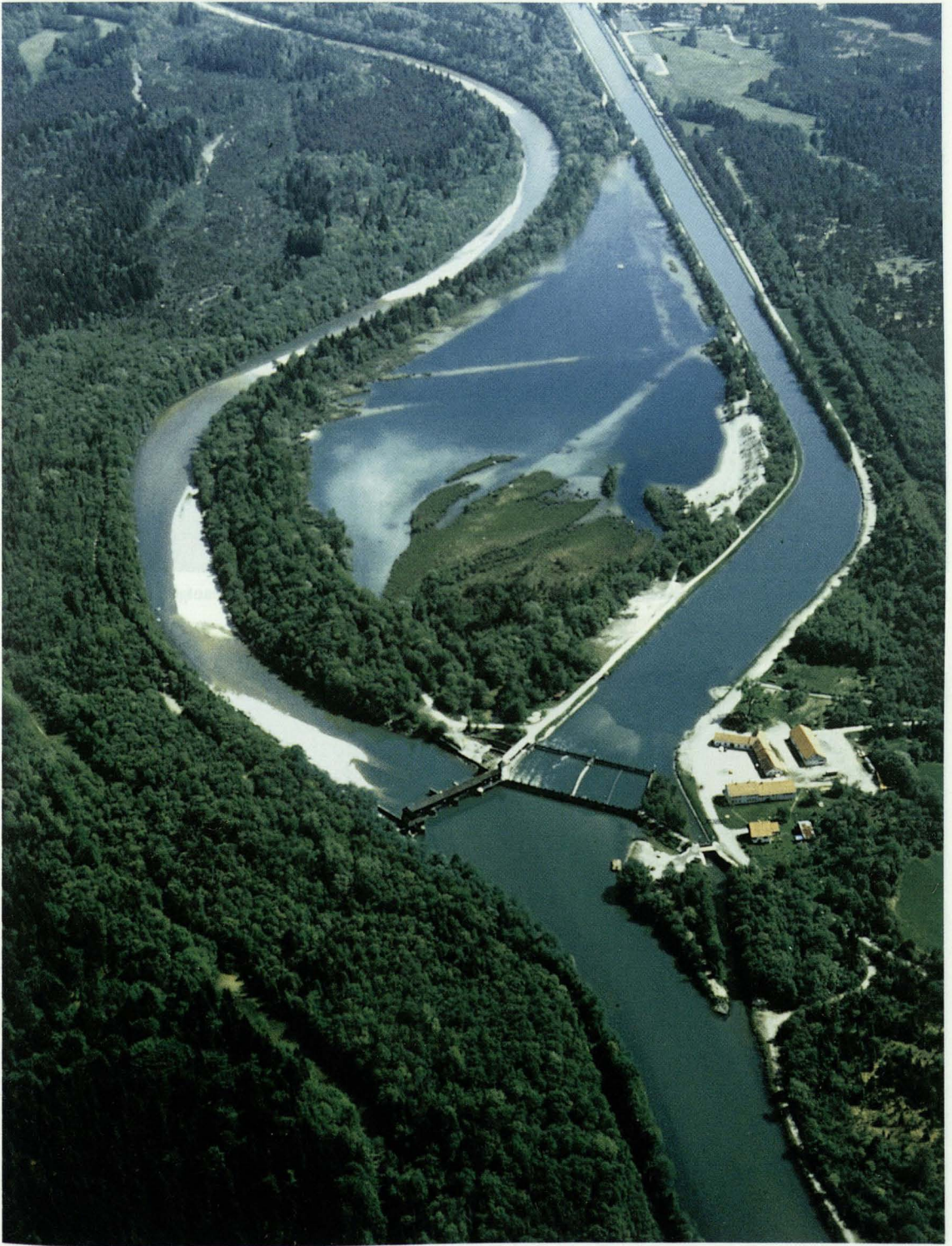
Abb. 11.6: Wehranlage Icking mit der regulierten Isar (links) und dem Ausleitungskanal (rechts).
