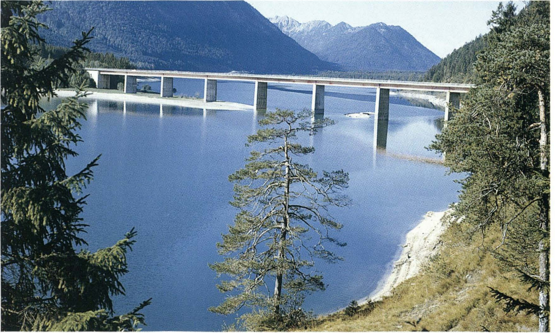
Abbildung 6.9: Der Sylvensteinspeicher wirkt als Geschiebefalle. Dadurch verliert die Isar ein wesentliches Merkmal eines Wildflusses.
