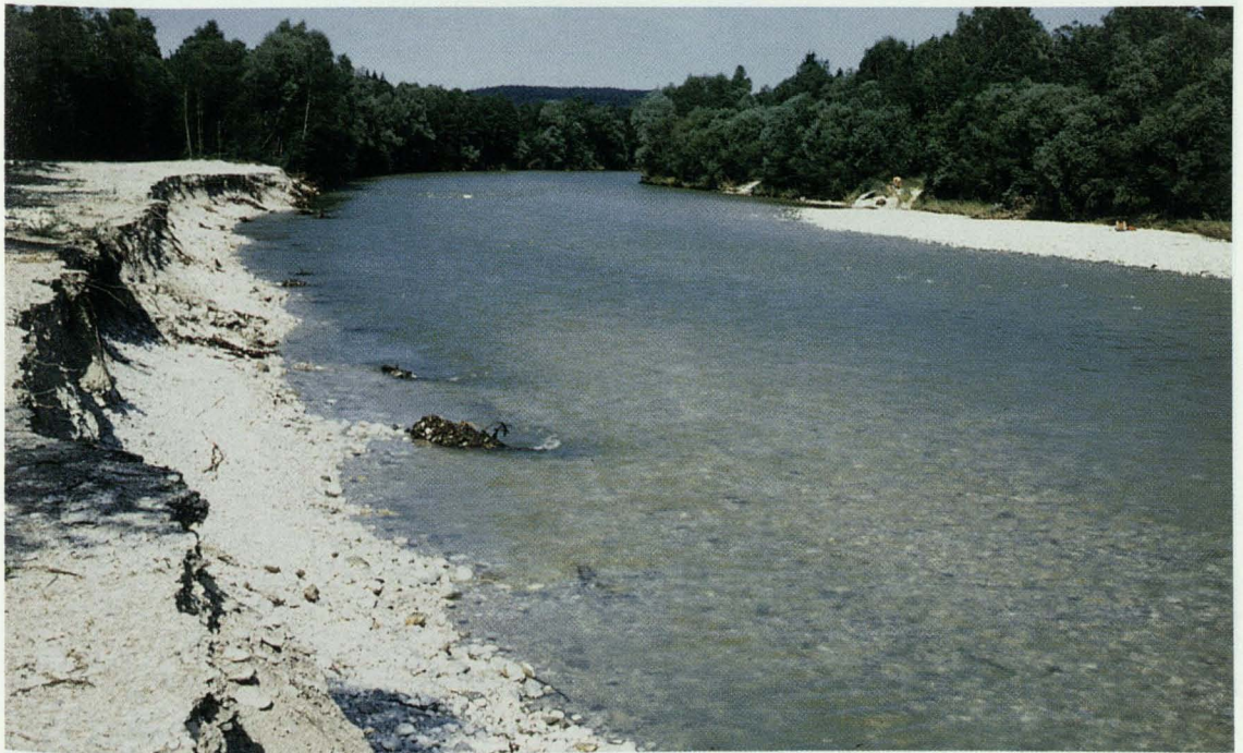
Abb. 11.10: An der 1996 zurückgebauten Versuchsstrecke hat der Fluß seinen Lauf innerhalb von 2 Jahren um bis zu 18 m verbreitert.
