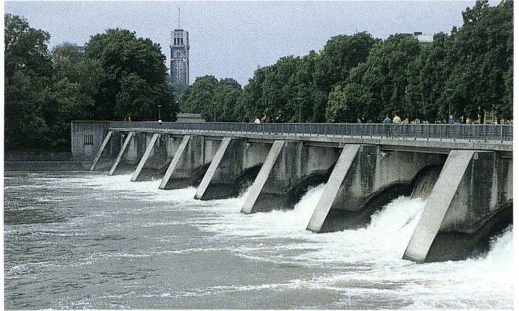
Abb. 3.20: Unterhalb der Maximiliansbrücke muß die Isarsole mit einer Schwelle gegen die Eintiefung geschützt werden.
