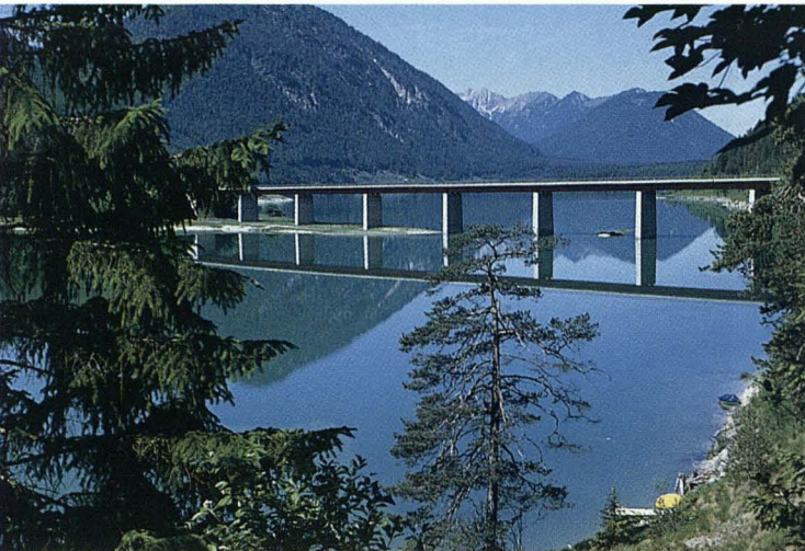
Abb. 3.11: Der Sylvensteinspeicher verändert den Isarabfluß bei Niedrigwasser und bei Hochwasser. Er hält das Geschiebe zur Gänze zurück.
