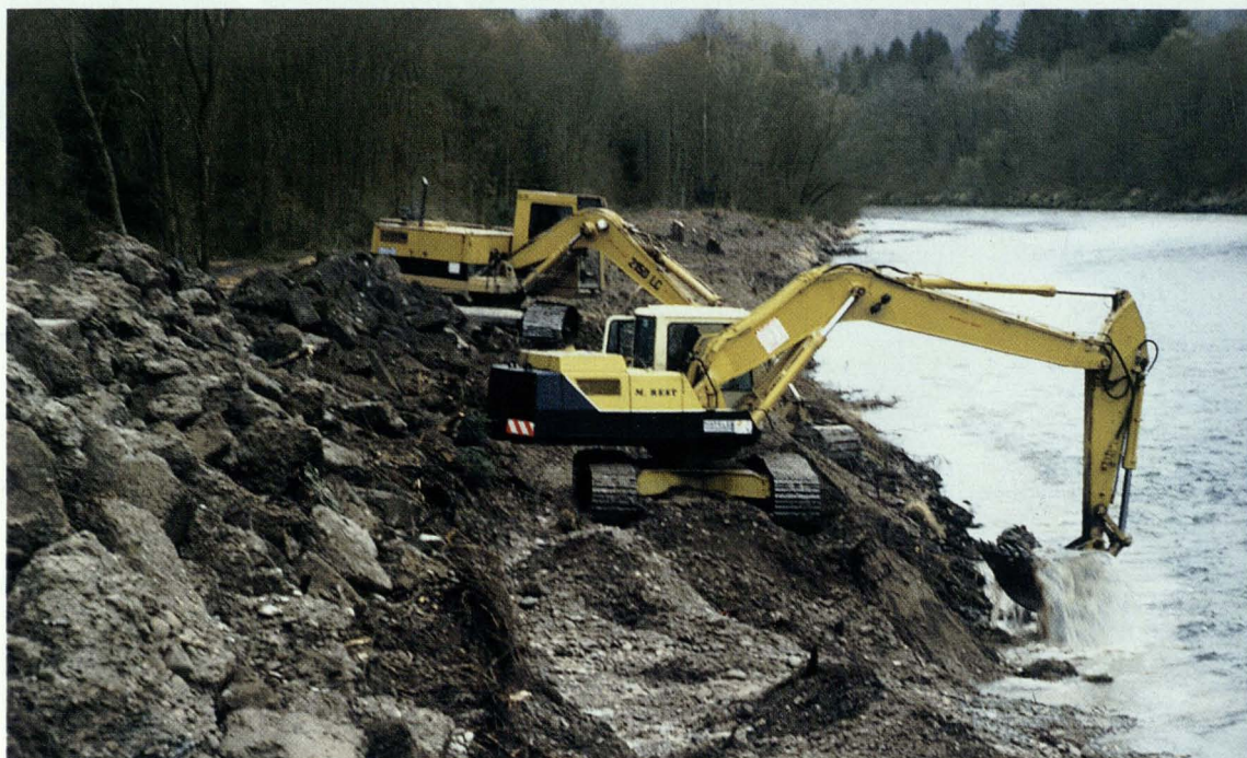
Abb. 11.8: Nach Rodung der Ufergehölze, Entnahme der Betonplatten
