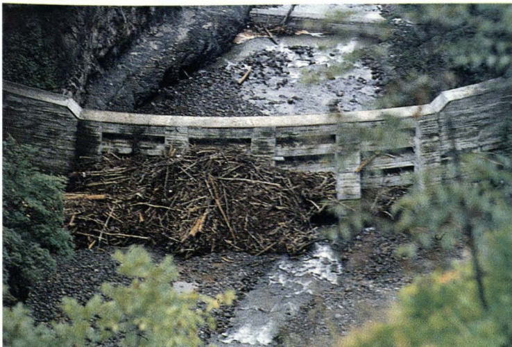
Abb. 2.8: Das hier an einer Wildbachsperre gefahrlos aufgefangene Wildholz könnte an Brücken und Engstellen durch Verkläusung schwere Schäden verursachen.
