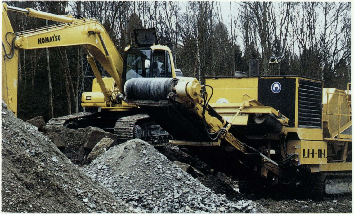
Abb. 11.9: Ein Schredder zerkleinert die Betonplatten; das gebrochene Material wird der Isar als Geschiebe wieder zugegeben.
