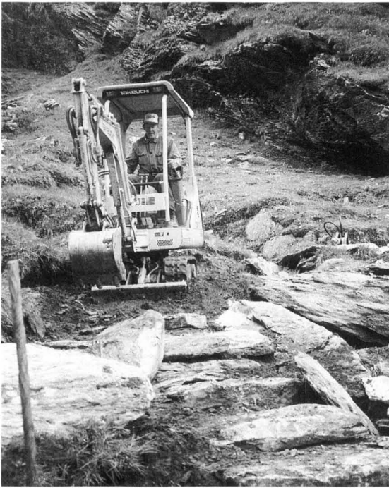
Abb. 33: Einbau von Stufen mit Bagger.
