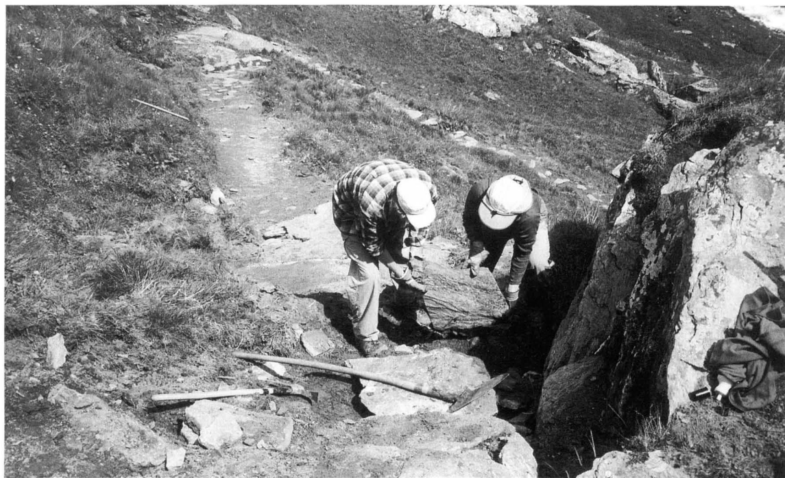
Abb. 32: Einbau von Stufen von Hand.
