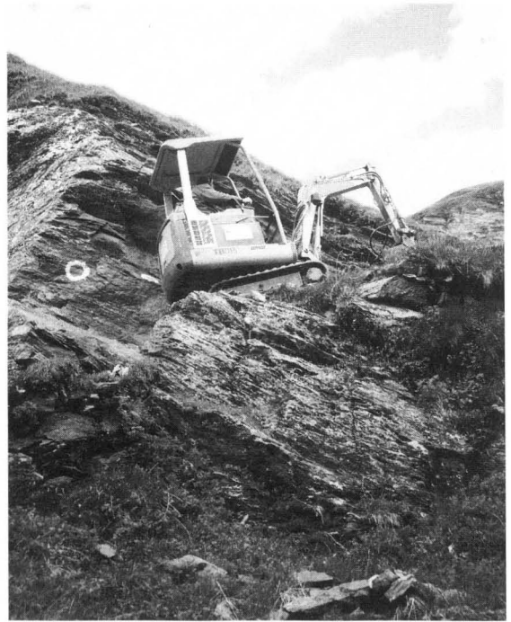
Abb. 34: Unglaubliche Leistungen unseres Baggerfahrers im Bereich Blaues Wandl.
