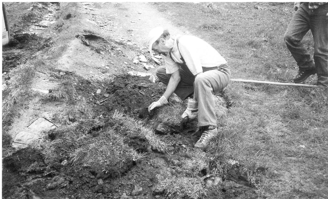
Abb. 27: Wiedereinbau von Rasensoden, die beim Aushub von Wasserauskehrungen oder beim Abtrag von talseitigen Rasenbulten gewonnen wurden.
