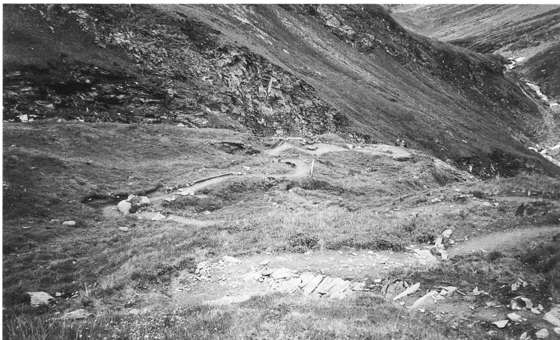
Abb. 7: Wegeführung durch Absperrungen nach Rekultivieren der Nebenwege, ca. 2400 m.
