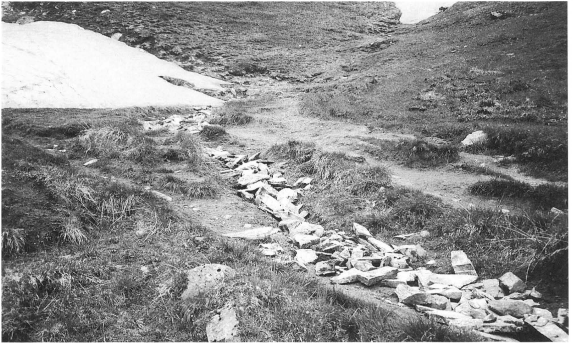
Abb. 15: Auffüllung mit Steinen von tieferen Rinnen.
