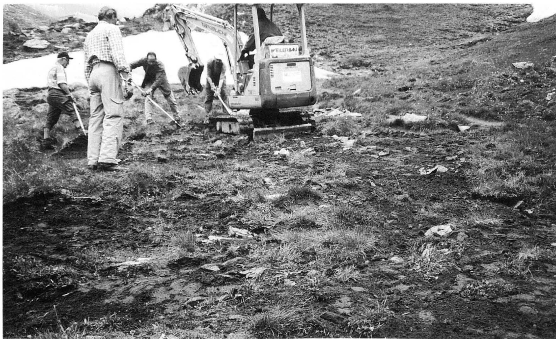
Abb. 18: Einebnung des Bereiches auf ca. 2280 m, einsetzen der vorhandenen Rasensoden als Initialpflanzung zwischen angesäten Bereichen.
