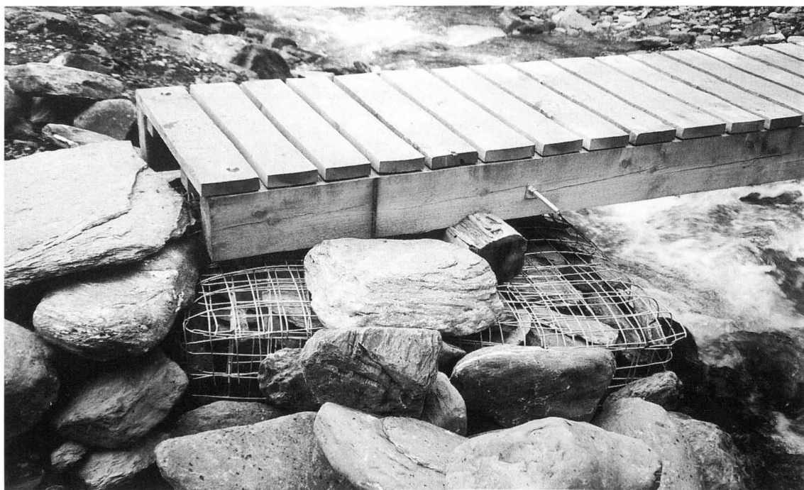
Abb. 21: Drahtschotterkorb mit Trägern.
