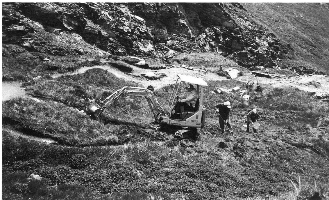
Abb. 17: Einebnung, Nachplanie, Ansaat von durch vielen Abkürzern durchzogenem Bereich auf ca. 2450 m.
