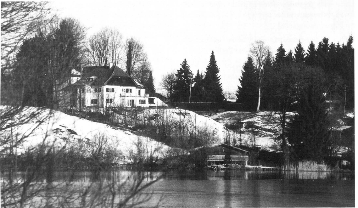
Das fragliche Grundstück nach der Holzaktion
