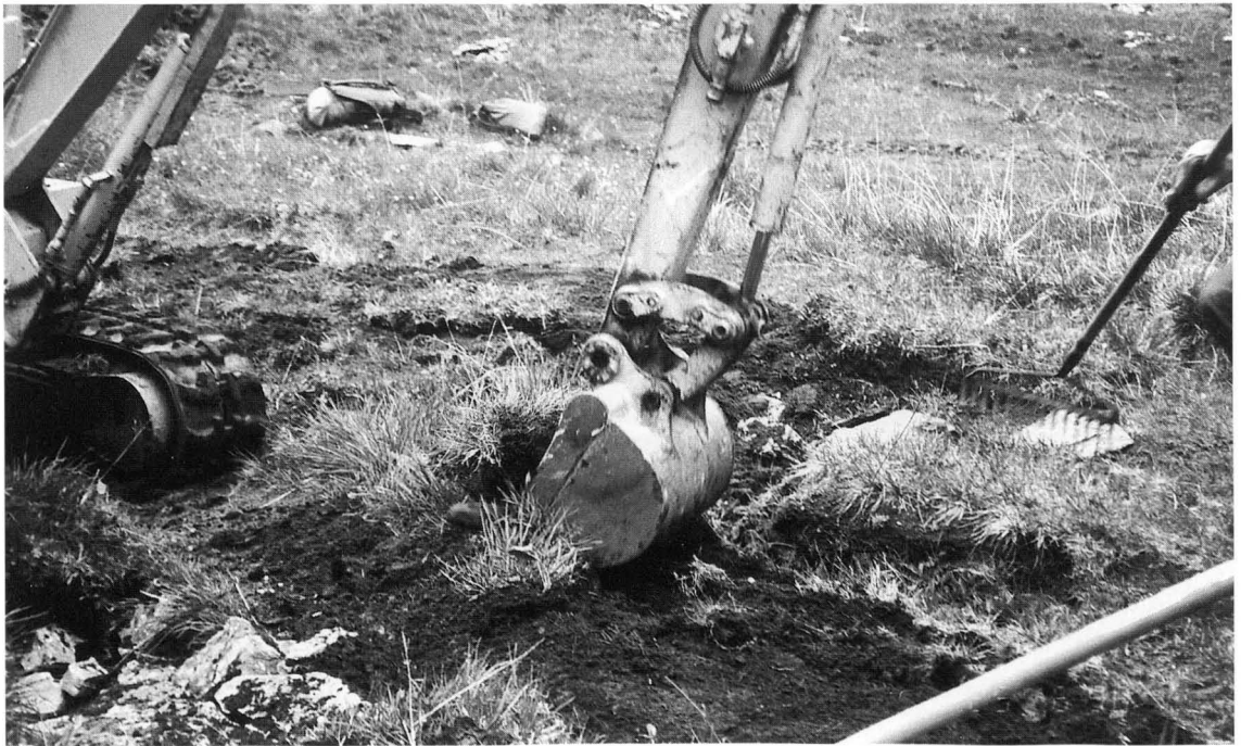
Abb. 16: Maschineller Wiederauftrag von abgehobenen Rasensoden.
