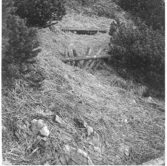
Abb. 6 a: Fellsschuttfläche unmittelbar nach Durchführung der Mulchsaat im Sommer 1991
