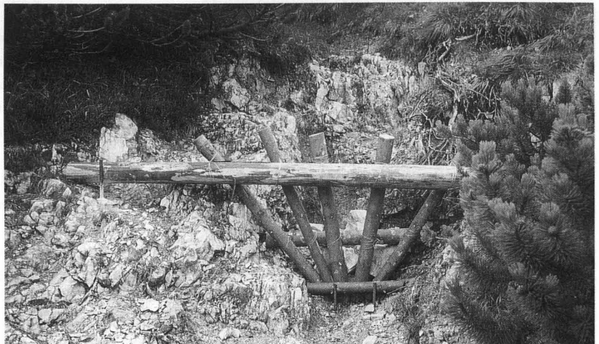
Abb. 4 a: Erosionsrinne verbaut mit einem Holzrechen im Sommer 1988
