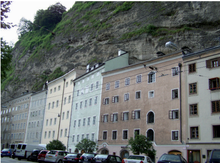
Abb. 2: Häuser der Gstättergasse (Foto Katrin Pfeifer).
