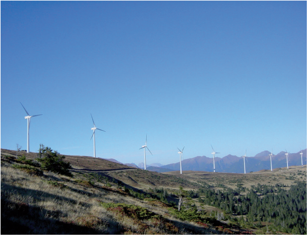
Abb. 79: Windpark auf dem Kamm der Wölzer Tauern/Steiermark (Foto: www.windpark.com ).
