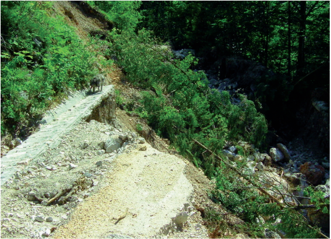
Abb. 44: Röthelbachstraße bei Schneizlreuth/Lkr. Berchtesgadener Land als Menetekel (Foto: W. Guglhör, 2.9.11). Das war noch 2010 eine LKW-fähige Forststraße. Sie hat seit 1964 fast schadensfrei gehalten, im Juli 2010 wurde sie durch einen Starkregen von 140 l in 90 Minuten auf mehreren Teilstücken von zusammen fast 300 m Länge weggespült.
