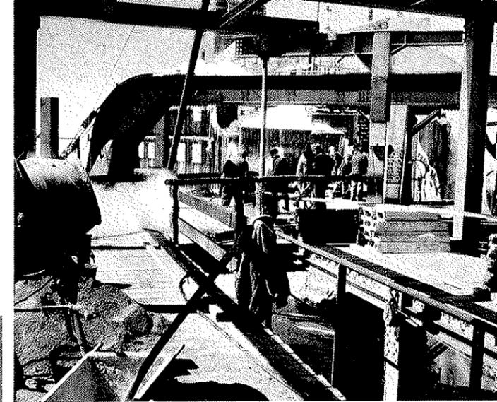
Die höchste Baustelle der Bundesrepublik lag in fast 3000 Meter Höhe und war 60 Meter lang. Hier entstand zwischen Münchner Haus (im Hintergrund) und der alten Gipfelstation die mehrstöckige Gipfelterrasse mit eingebauten Rolltreppen und einem Selbstbedienungsrestaurant. 400 t Stahlkonstruktionen wurden für die Anlage am Zugspitzgipfel eingebaut.
