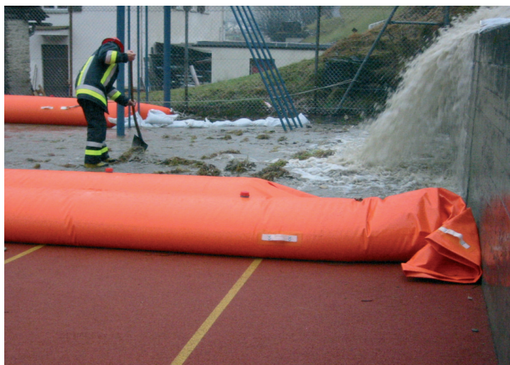
Abb. 6: Erfolgreicher Einsatz eines Katastrophen- hochwasserschutz- systems in Vals im Jahre 2002 (Bild: Feuerwehr Vals).
